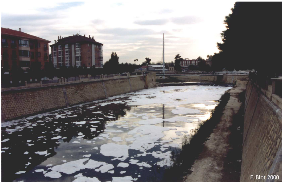
Figure 37 – Pollution visible du Segura au cœur de la ville de Murcia
