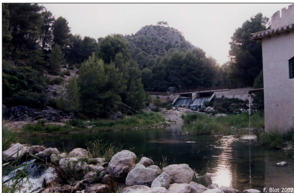
Figure 33 – Puits adjacent au Segura dans sa partie amont
