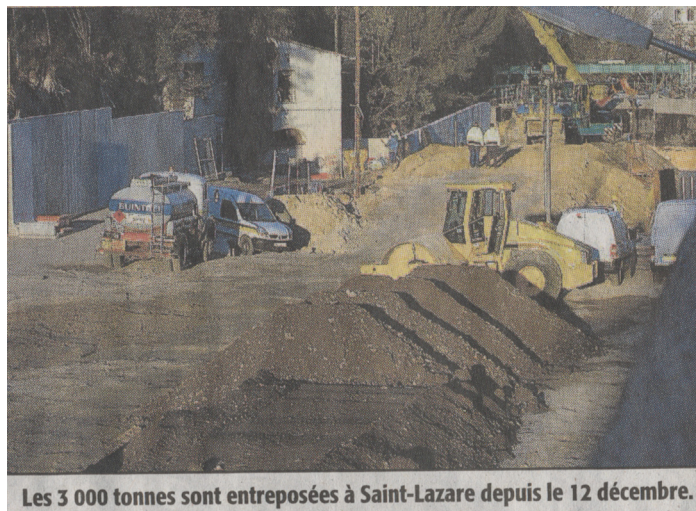
Photo 32 : Dépôts de mâchefers à Montpellier
