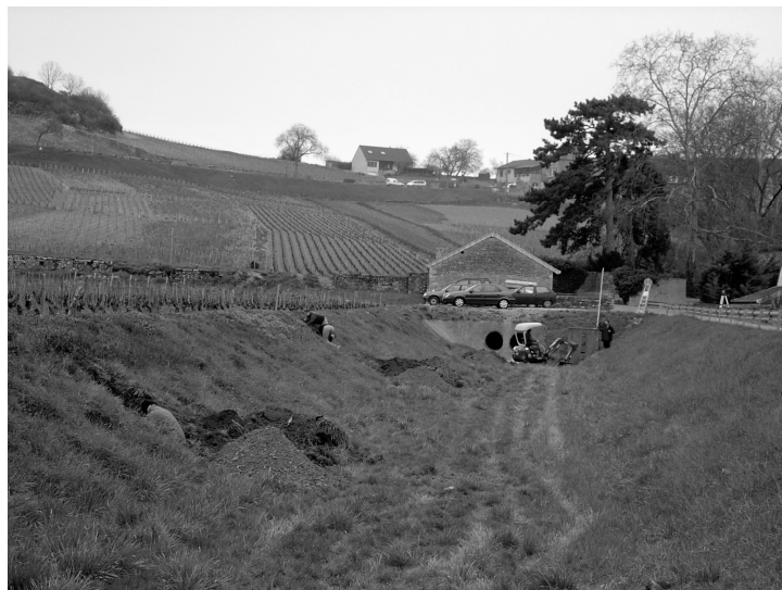
Figure 6.5. Photographie des coupes réalisées sur le flanc Nord du bassin de décantation de la Combe Danay à Monthélie. La route située à droite de la photographie est à la même altitude que la parcelle amont, et surplombe l'aval de deux mètres.
