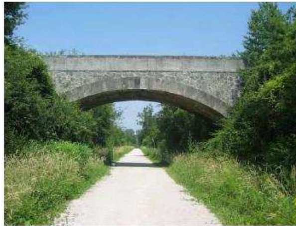
FIG. 5.10 – Le pont SNCF de la Millette
