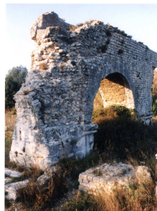
FIG. 2.11 – Modèle des maçonneries en grand appareil en partie inférieure, et en petit appareil et maçonnerie de blocage en partie supérieure, du deuxième aqueduc d'Arles, au vallon des Arcs, à Fontvieille (Cotte et al. (2001))
