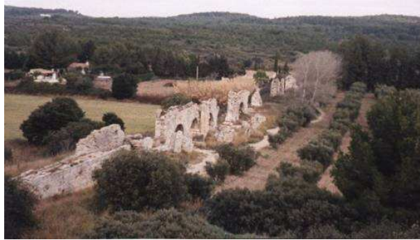
FIG. 2.10 – Vue générale de l'aqueduc d'Arles et de l'aqueduc des moulins, au vallon des Arcs, à Fontvieille.
