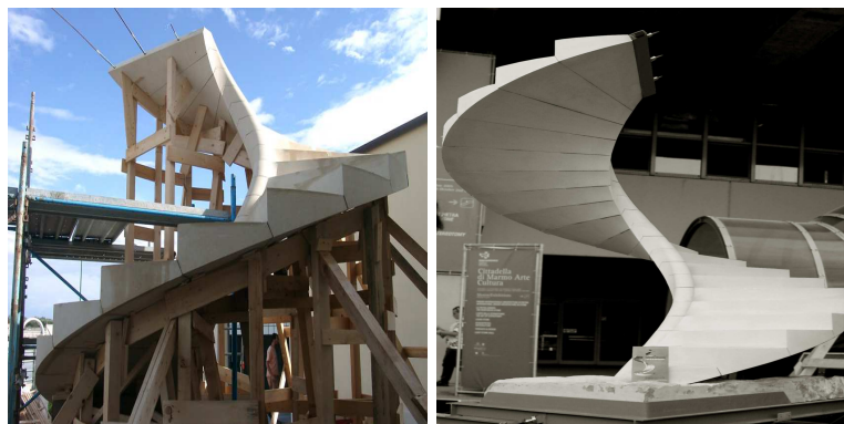
FIG. 3.32 – L'escalier sur chantier, et à la 40 ième foire de Vérone
