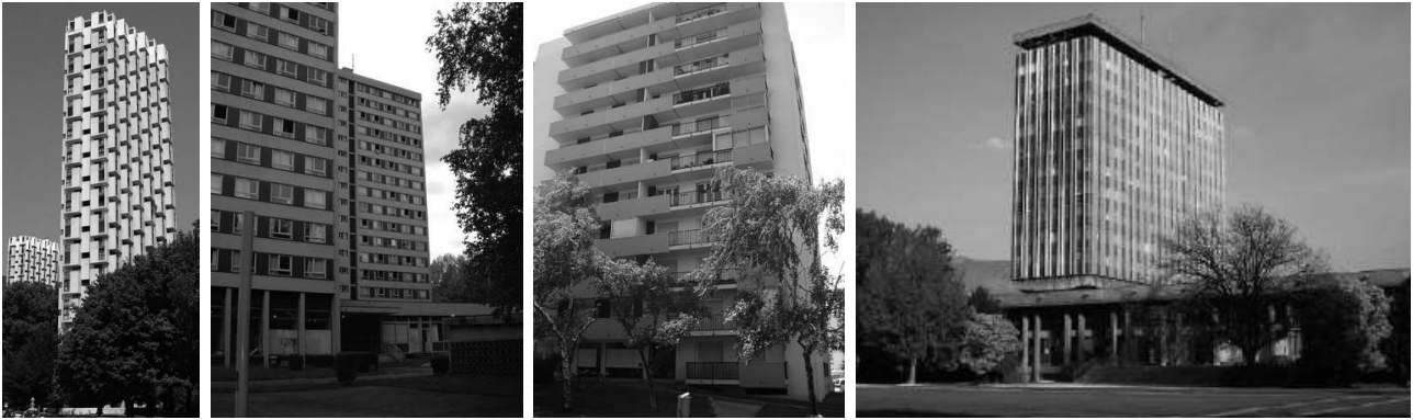
Figure 3.1 : Les bâtiments étudiés, de gauche à droite : la Tour Mont-Blanc, les Tours jumelles ARPEJ, l'immeuble 7 rue Paul Claudel et l'Hôtel de Ville de Grenoble. The studied buildings (from left to right) : Mont-Blanc Tower, the ARPEJ Twin Towers, the building 7 P. Claudel Street and the Grenoble City Hall.
