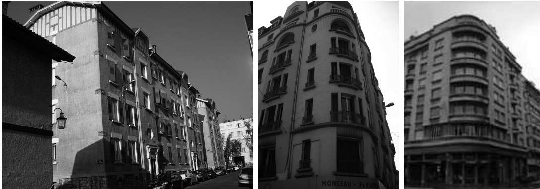
Figure 4.7 : Transition entre le béton et la maçonnerie à Grenoble, les années 1920 à 1950. A gauche : la Cité OPHBM de l'Abbaye (CM_43, type MA9); Au centre : immeuble en maçonnerie avec moulage en béton en façade à l'angle des Cours Jean Jaurès et Berriat (CM_35, type MA10); A droite : immeuble en béton armé des années 1930 (type BA1), difficile à différencier du bâtiment en maçonnerie au centre (Guéguen et Vassail, 2004). Concrete/masonry transition in Grenoble from the 1920s to the 1950s. Left : Low cost dwellings (OPHBM) in Abbaye area (CM_43, type MA9); Centre : masonry building with concrete moldings in the intersection of J. Jaurès and Berriat Boulevards (CM_35, type MA10); Right : Reinforced concrete building of the 1930s (type BA1). It is difficult to make a difference between this type and the masonry type in the central picture (Guéguen et Vassail, 2004).
