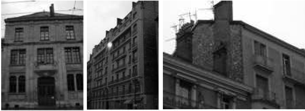
Figure 4.6 : Bâtiments en maçonnerie de meilleure facture de Grenoble. A gauche : un bâtiment public du XIX e siècle de la place de Verdun (type MA6) ; Au centre : un immeuble bourgeois avec des planchers en béton (CM_30, MA7) ; A droite : un immeuble populaire du début du XX e siècle (type MA8). D’après Guéguen et Vassail (2004). Masonry buildings of Grenoble with higher standard. Left : public building of the 19 th century on the Verdun’s square (type MA6) ; Centre : upper-middle-class building with concrete floors (CM_30, MA7) ; Right : working-class dwelling of the beginning of the 20 th century (type MA8). From Guéguen et Vassail (2004).
