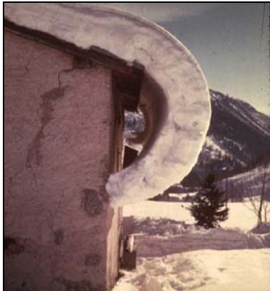
Figure 1.11 : Neige sur un toit. Sous l'effet de la différence de température entre la partie coté soleil et la partie coté toit, la neige s'est déformée plus rapidement là où la température est la plus élevée.
