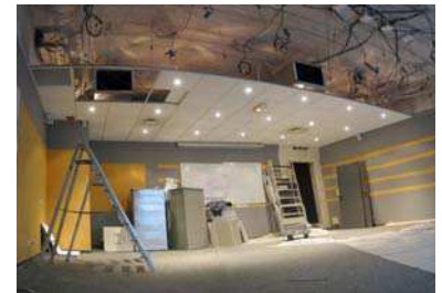
Figure 4: Rehaussement d'une partie du plafond.
