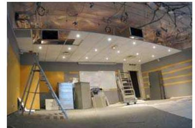
*Figure 4: Rehaussement d'une partie du plafond.*
