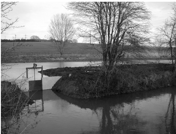
Photos 37, 38 et 39 : La section renaturée de l'Aubance à Charcé Saint-Ellier
