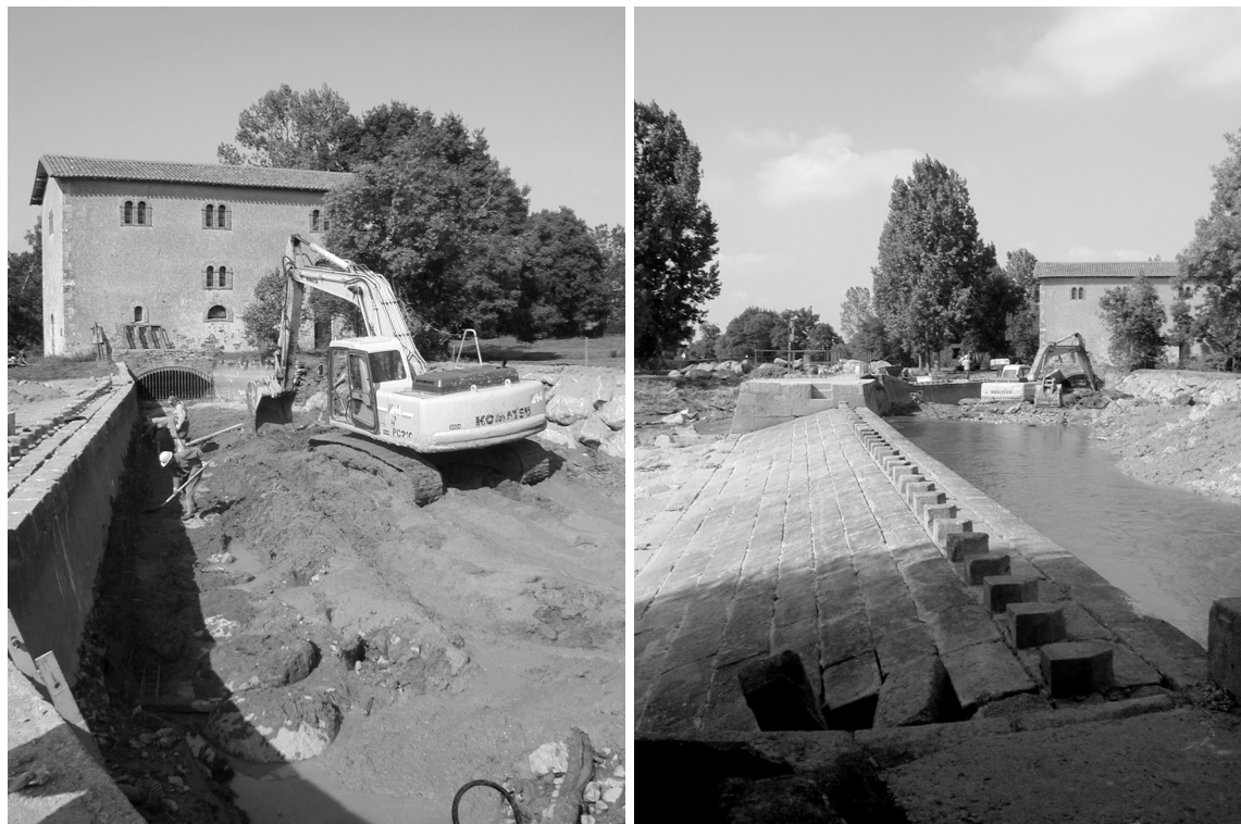
Photos 33 et 34 : La restauration patrimoniale du moulin du Guy
