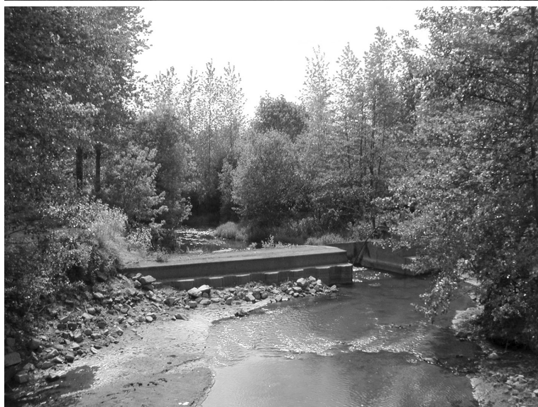
Photos 40 et 41 : L'expérience d'abaissement du plan d'eau de la Motte à Mouzillon, Vues amont et aval (clapet abaissé)
