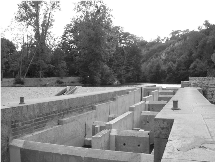
Photos 35 et 36 : Les franchissements piscicoles
