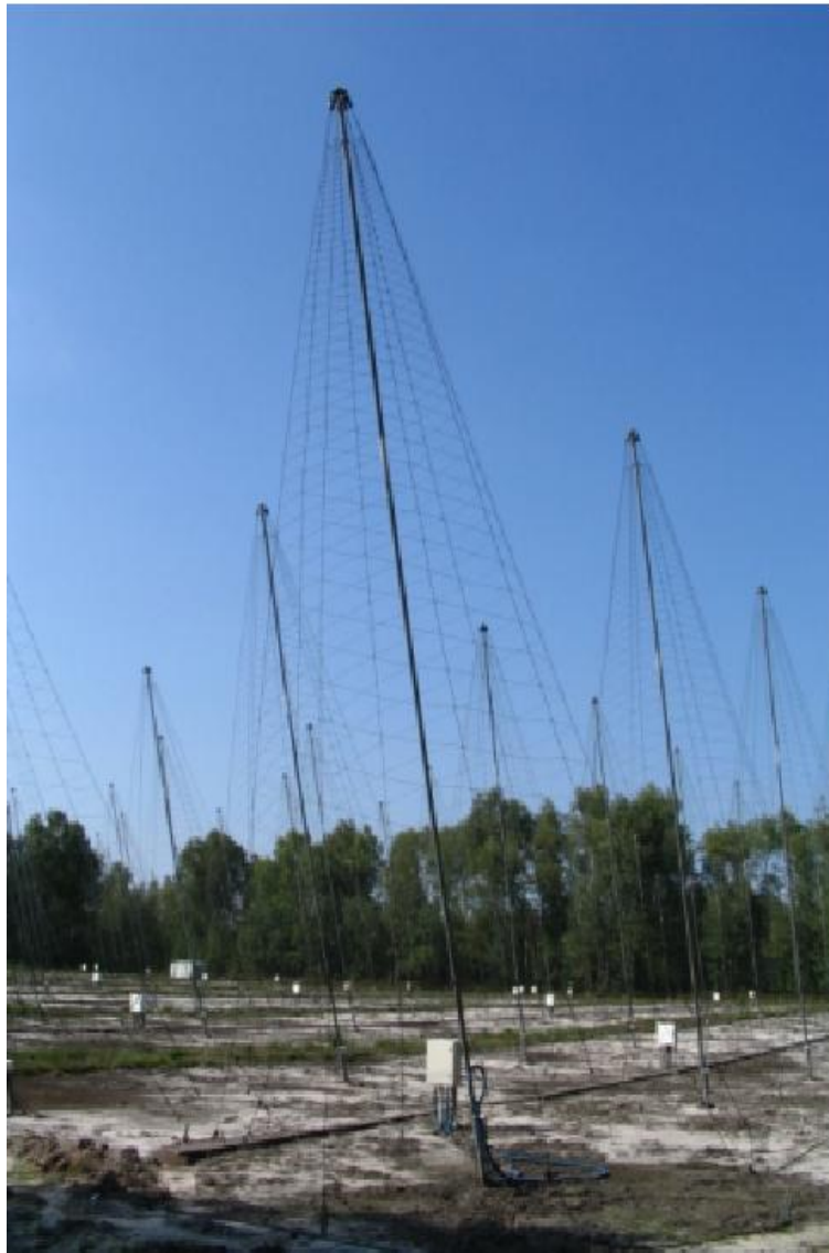
FIG. 4.4 – Vue du réseau décimétrique (DAM) de l'observatoire radio astronomique de Nançay, qu'utilise en partie le démonstrateur CODALEMA, montrant une partie des 144 antennes log-périodiques qui le composent.
