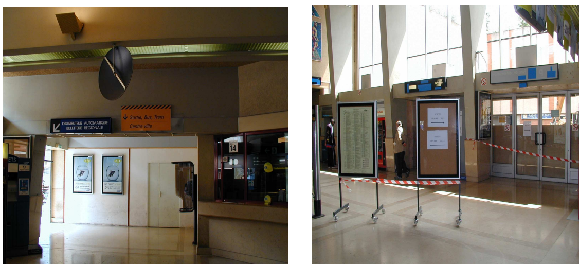
Figure 20 : Dispositif d'information à la Gare SNCF d'Orléans lors de travaux de rénovation
