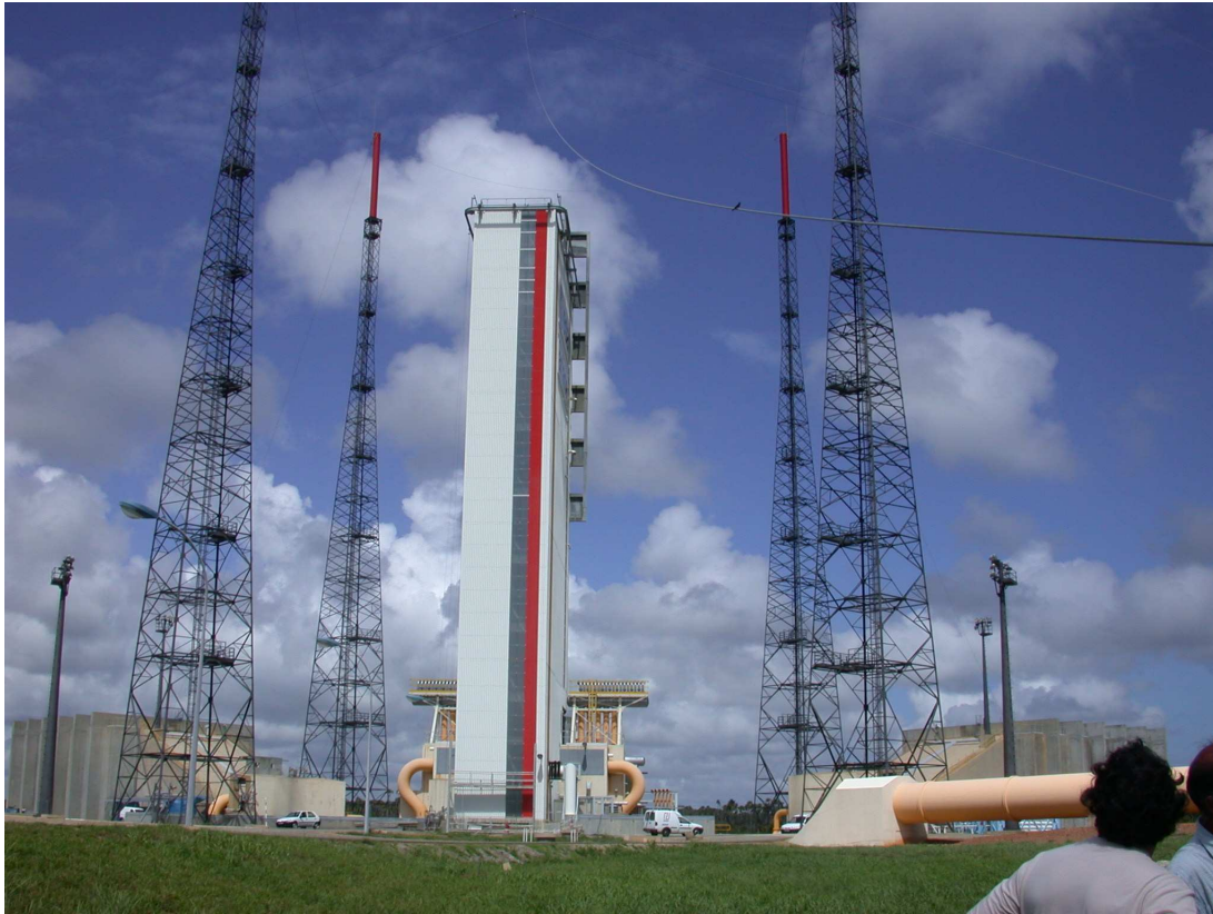
FIG. 3.6 – Vue de l'ensemble de lancement Ariane V. On distingue en particulier la protection secondaire de la tour Cazes avec au premier plan un câble de connexion à une prise de terre (protection secondaire de la tour)
