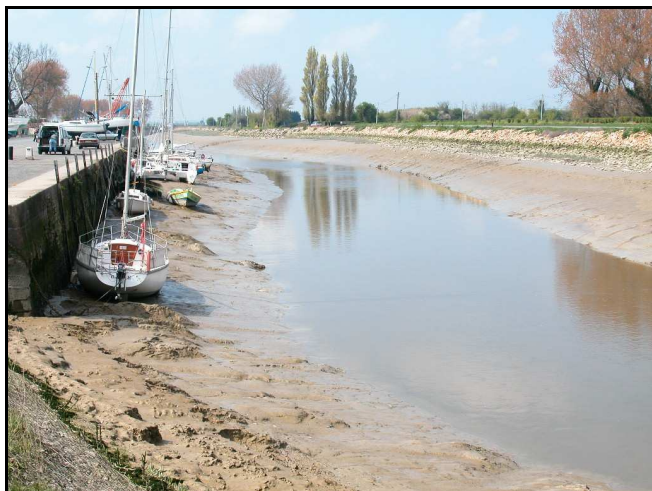
Epais dépôts de vase organique sur les berges à l'entrée du port d'Isigny-sur-Mer, juin 2004
