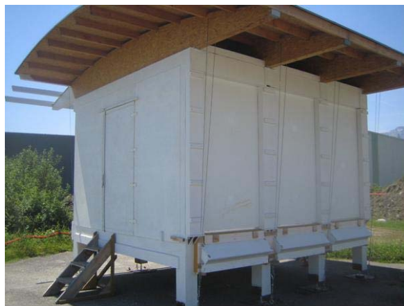
Figure 147 : Vue d'ensemble, angle Nord Est
