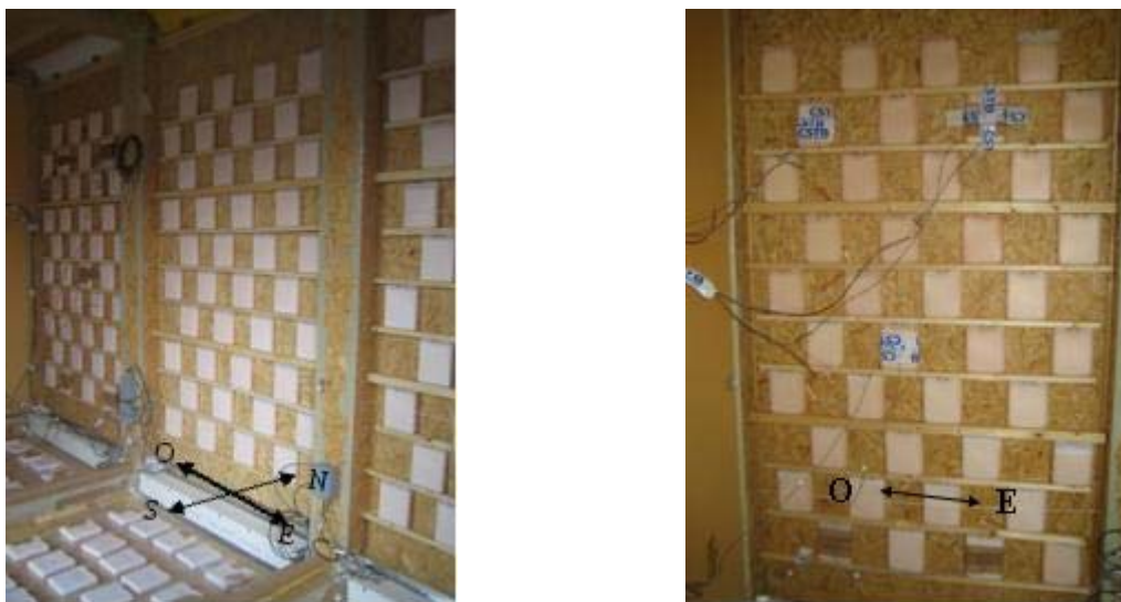
Figure 63 : Photographies des trois systèmes ventilés (à gauche) et du panneau nord équipé de fluxmètre (à droite), vu de l'intérieur du volume
