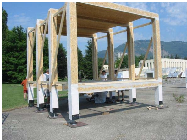
Figure 149 : Assemblage du squelette sur le site
