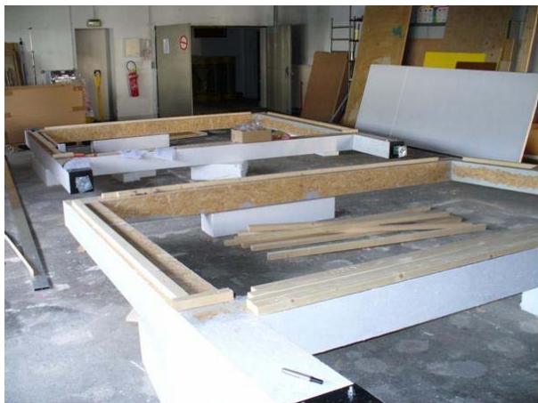
Figure 148 : Réalisation des portiques en atelier
