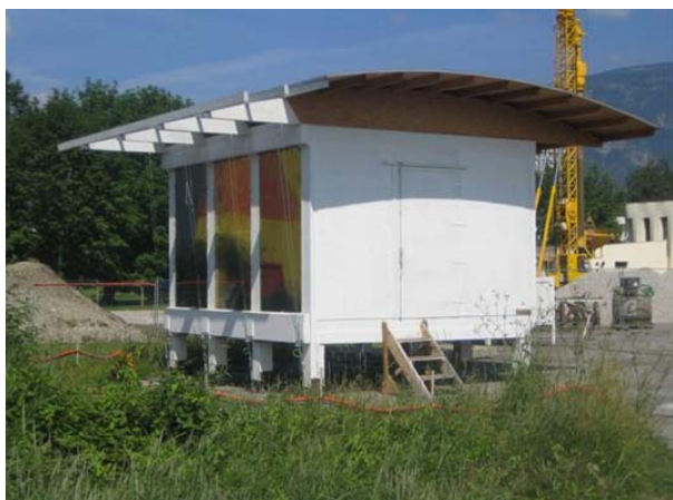
Figure 146 : Vue d'ensemble, angle Sud-Est
