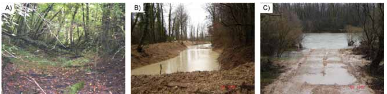
Photographie 4.6 - Lône des Carronières A) avant et B) après restauration, et (C) chemin d'accès au chenal principal pour la mise en dépôt des matériaux extraits
