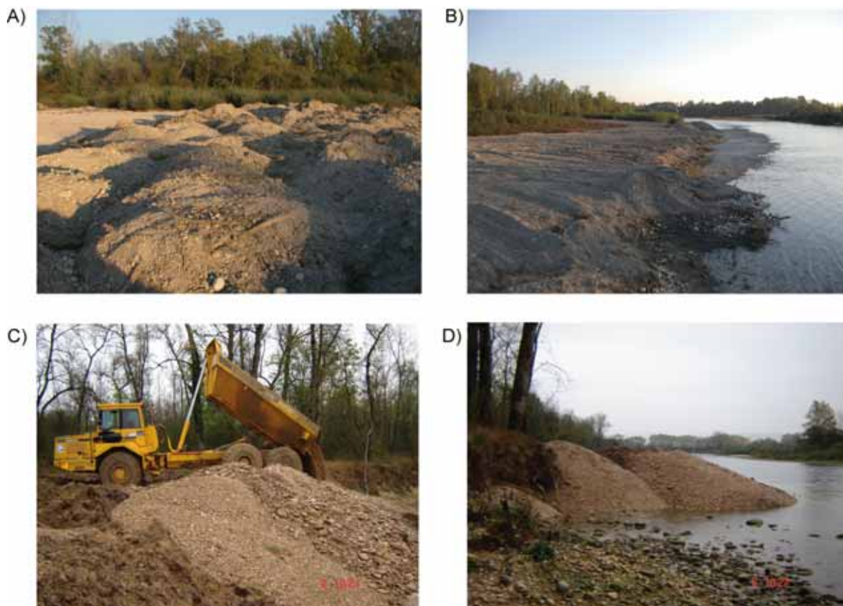
Photographie 4.7 – Mise en dépôt des sédiments extraits à partir du curage du bras mort de Bellegarde par (A et B) reconstruction artificielle d'un banc fortement dégraissé et (C et D) dépôt en masse dans des secteurs de forte contrainte hydraulique en période de hautes eaux (clichés CREN et ONF)
