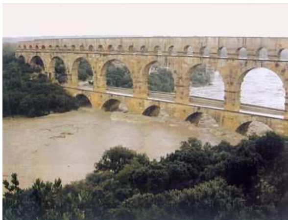
FIG. 3.10 : Photographie du Pont du Gard avec le Gardon en crue pour l'évènement du 8 au 9 septembre 2002. L'eau atteignait le haut de la première arche du pont, soit une hauteur d'environ 20 mètres...
