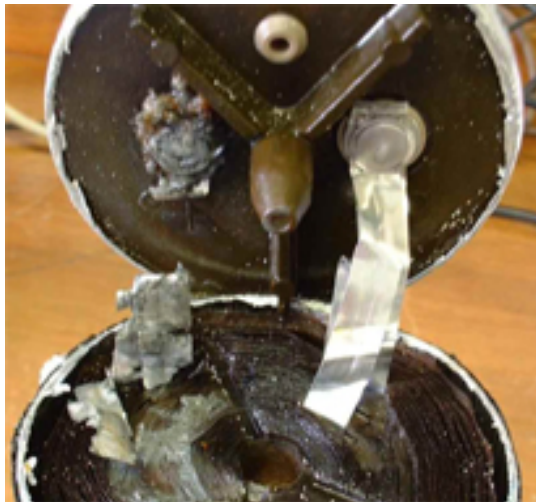
Figure 4.6 : Corrosion de l'anode d'un condensateur 4700 \mu F, 500 V [1]
