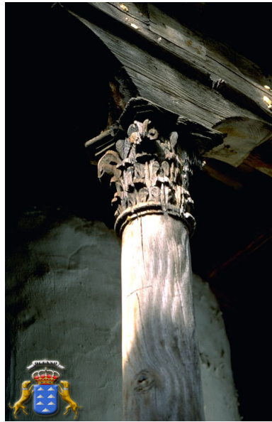
Fig. 2.5: Column and capital made from Pinus canariensis wood, La Oratava (from Fototeca de la de la Consejería de Medio Ambiente y Ordenación Territorial del Gobierno de Canarias, www.gobcan.es/medioambiente/ ).
