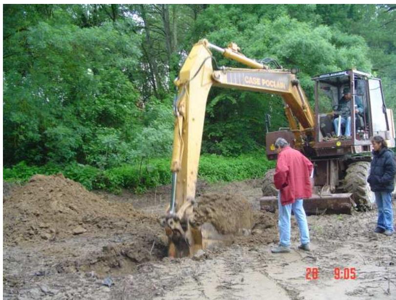
Photo 18 : Tranchée effectuée à la pelle mécanique dans le lit majeur ordinaire en rive gauche de l'Argent-Double à La Redorte, à proximité de la Dinée.
