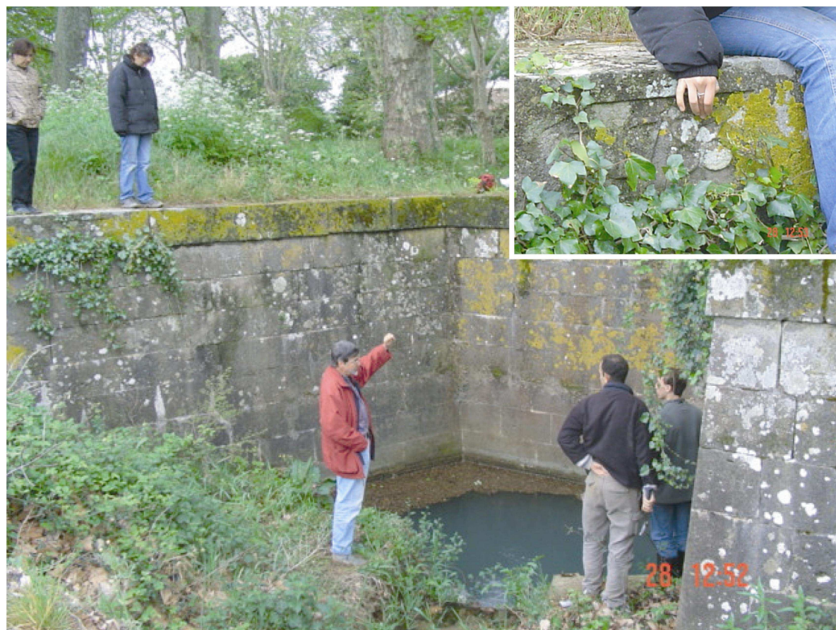
Figure 72 : Siphon construit sous le Canal du Midi. Source : Delorme-Laurent, 2007 ; d'après Delorme, 2004.
