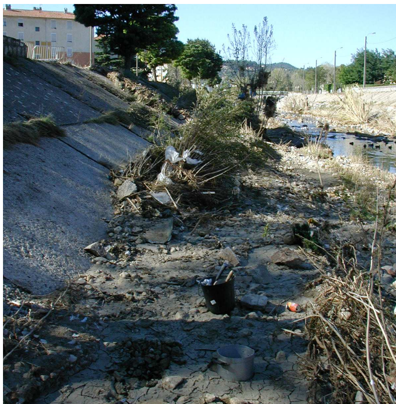
Photo 22 : Prélèvement à l'aval de la passerelle du pont, dans le lit mineur du Grabieux, en rive gauche, à Alès. Source : Cliché pris par S. Chave le 28 septembre 2002.
