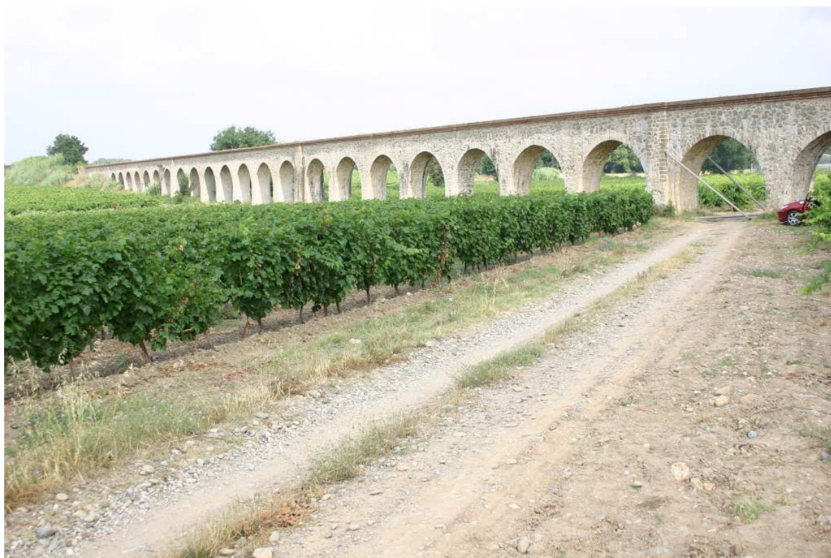
Photo 20 : Aqueduc traversant la plaine alluviale du Ruisseau d'Aiguille. Source : Cliché pris par J.-L. Ballais en juillet 2006.
