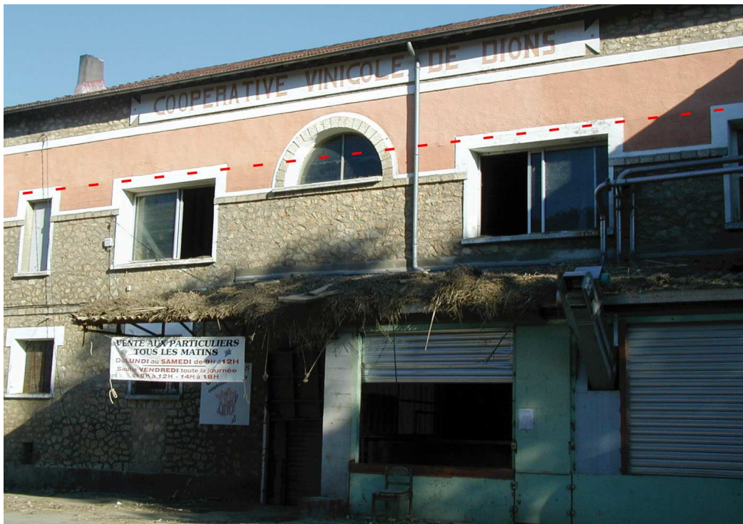
Photo 26 : Hauteur d'eau dans le lit majeur ordinaire, à la cave coopérative de Dions. Source : Cliché pris par S. Chave le 27 septembre 2002.
