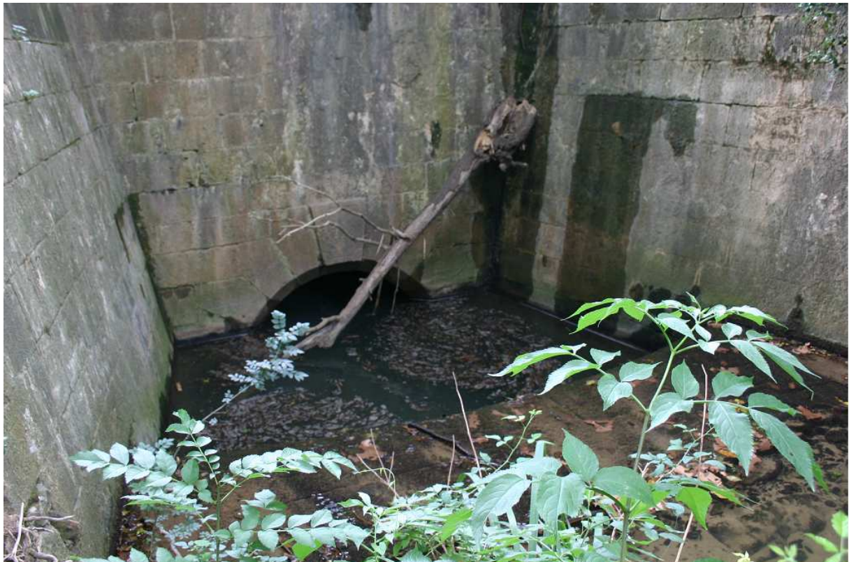
Photo 19 : Siphon permettant au Ruisseau d'Aiguille de passer sous le Canal du Midi. Source : Cliché pris par J.-L. Ballais en juillet 2006.
