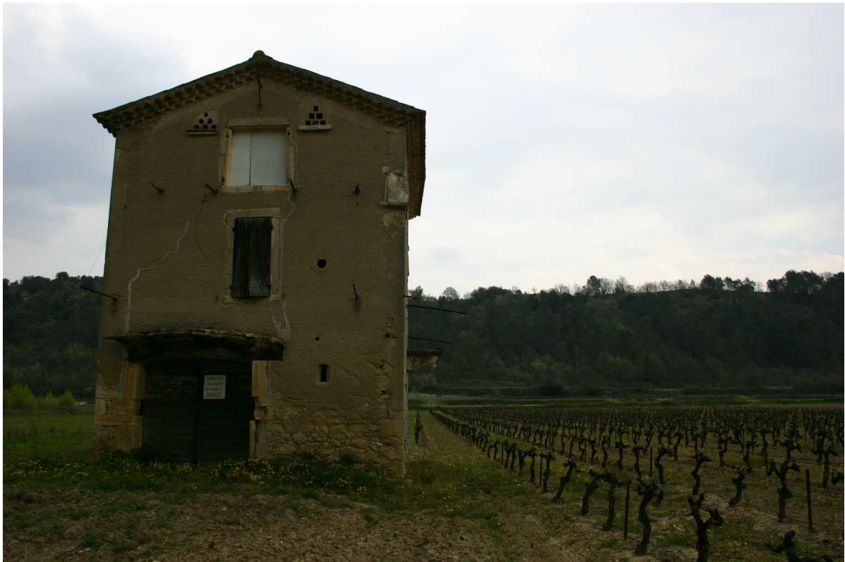
Photo 35 : Maison construite en 1839 dans le lit majeur de la Cèze en aval de Saint-André-de-Roquepertuis.
