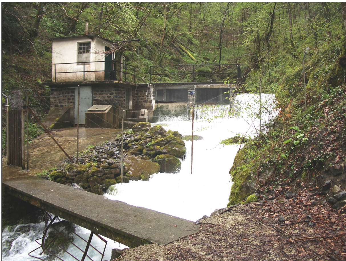
Photographiedu capatage de la source del'Ourtau lors d'une crue.
