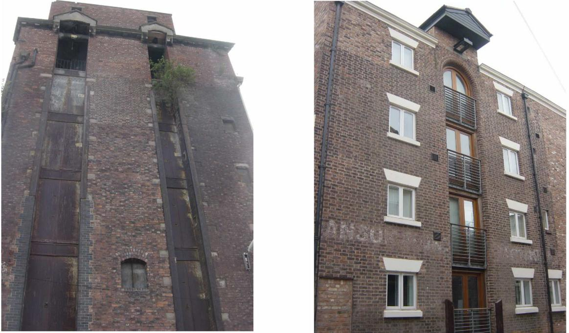
Les entrepôts : entre abandon et réhabilitation. Les baies permettant le chargement des marchandises sont mises en valeur, ainsi que les traces du système de poulie.
