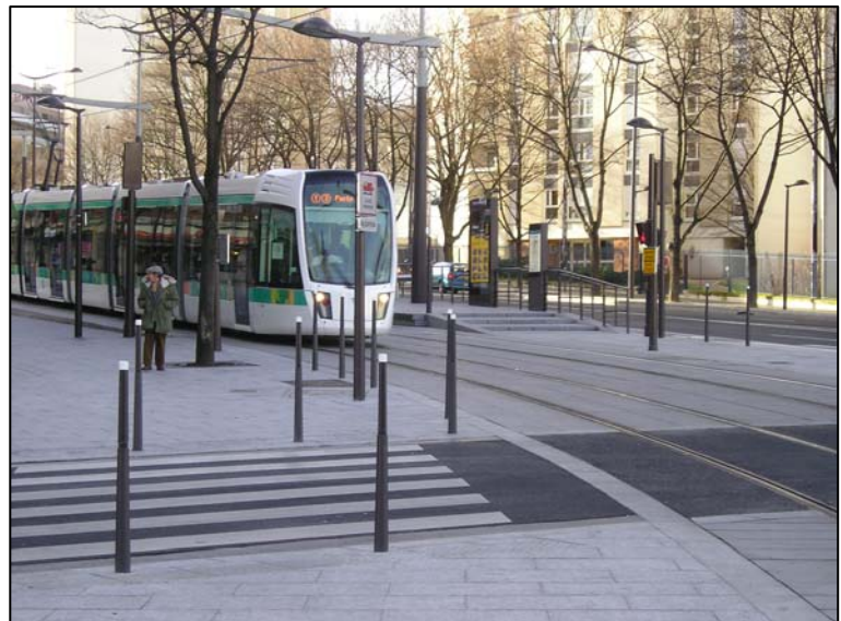
Figure n°45. Le boulevard Kellermann (13 ème arrondissement) requalifié à l'occasion de la mise en place du tramway : trottoirs élargis, réduction du nombre de files de circulation (janvier 2007)
