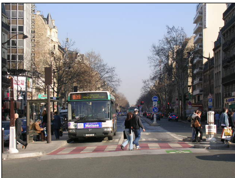
Figure n°46. Le boulevard Montparnasse réaménagé dans le cadre du programme « Mobilien » : les autobus circulent sur deux voies en site propre, au centre de la chaussée
