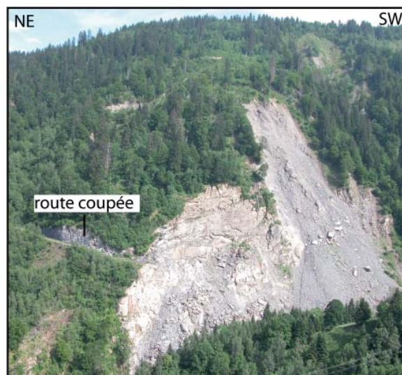
Figure II.19 : Glissement de la route de Combelouvière à la Thuile
