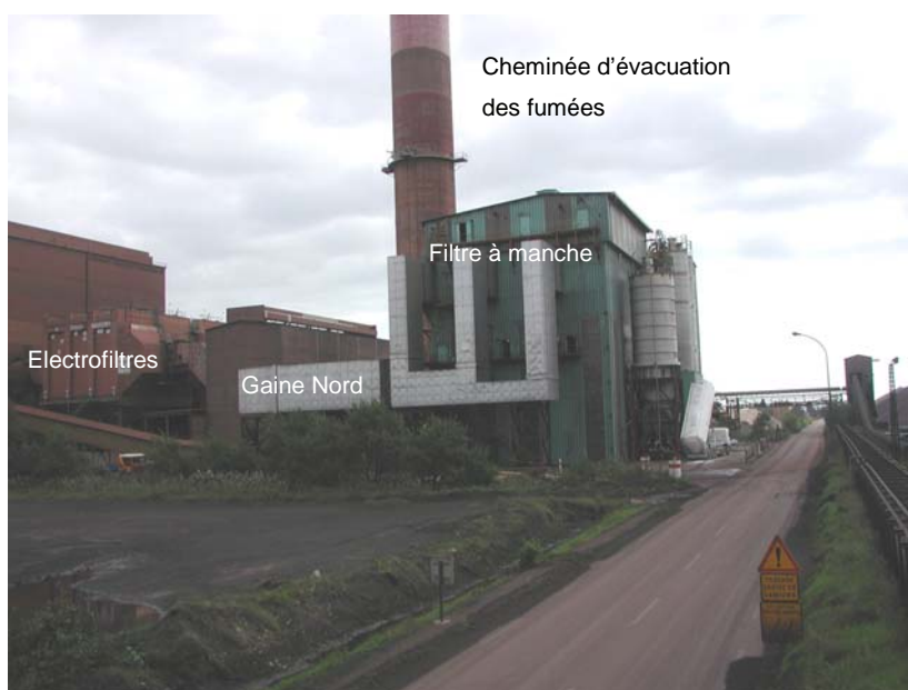
Figure II-3 : Photo des électrofiltres à l'atelier d'agglomération de Fos/mer.
