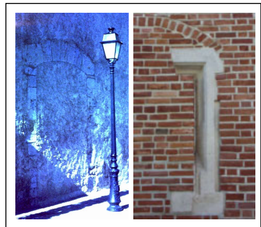
Figure 42 : Problèmes de reconnaissance d'objets réemployés, baie remplie du Palais des comtes de Provence, Brignoles, Var, et baie enfouie de la façade sur rue du Budynek Copernicus, Cracovie, Pologne
