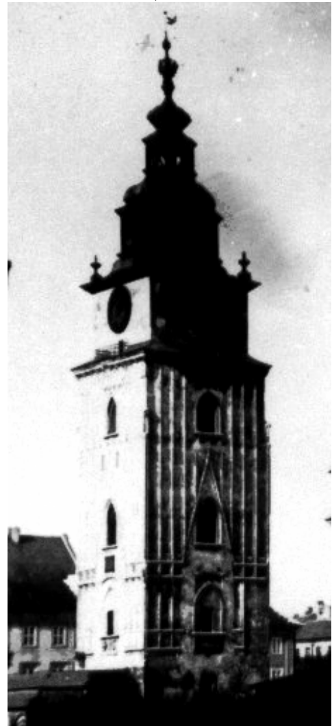
Figure 30 : Le beffroi de l'ancien hôtel de ville avant restauration (photographié à la fin du XIXème siècle)
