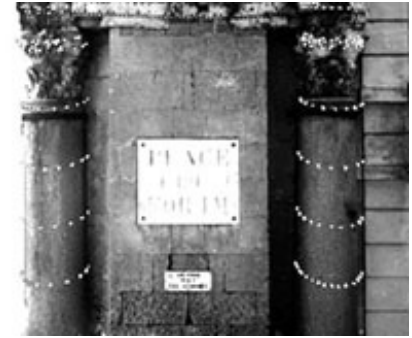
Figure 65 : Points relevés à la surface de fûts de colonne (voir [Florenzano et al, 1996a] )
