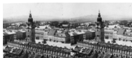
Figure 104 : Stéréogramme montrant Sukiennice et Kramy Bogate, pris vers 1860 depuis le clocher de la Cathédrale.
