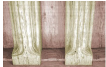
Figure 20 : Un plafond en bois restauré, on reconnaît solives, murières, entretoises, plancher.
