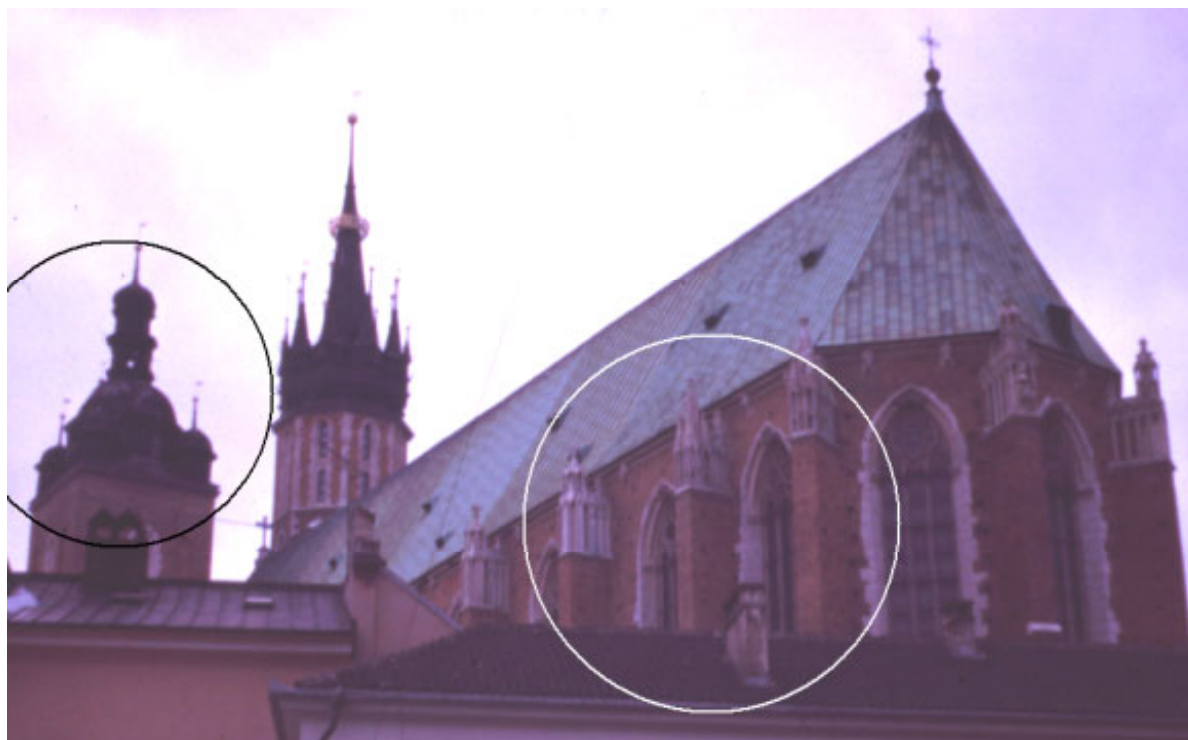
Figure 89 : L'église gothique Ste Marie de Cracovie, contreforts en lieu et place des arcs-boutants et couverture du clocher Sud par un dôme
