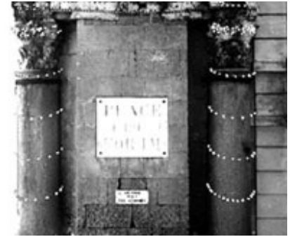
Figure 65 : Points relevés à la surface de fûts de colonne (voir [Florenzano et al, 1996a] )
