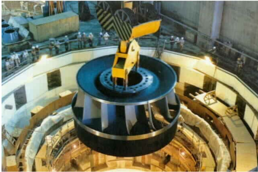
Turbine du barrage hydraulique d'Itaipu (Pérou)
