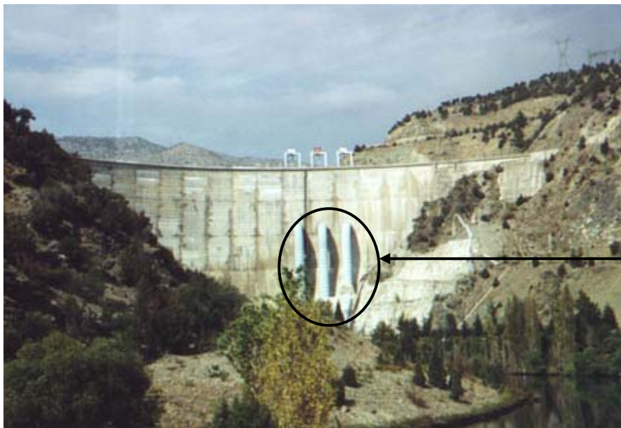
Conduites forcées du barrage de Gokcekaya (Turquie)
