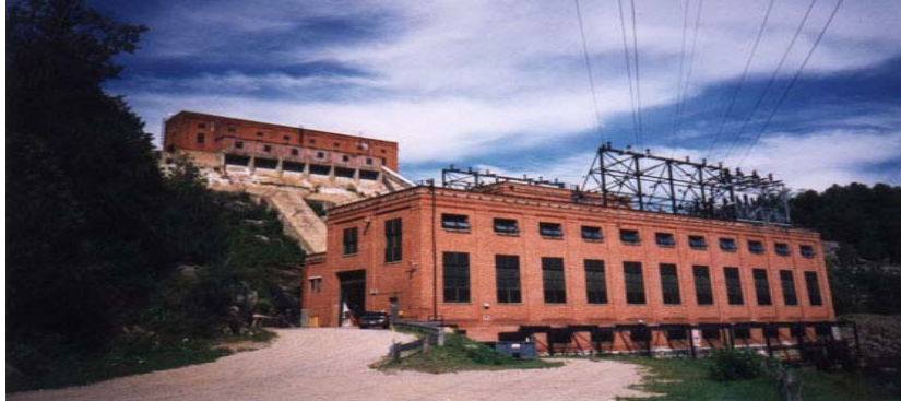
Centrale Hydraulique (Canada)
