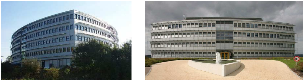
Figure 1.9 : Vues de l'immeuble de bureaux Energion (Faigle, 2005)
