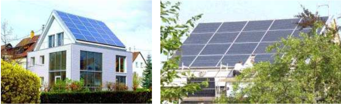
Figure 1.10 : Vues de la maison à énergie positive de Fellbach (Chlela et al, 2005)
