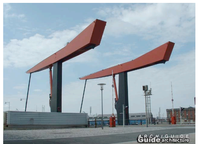
Pont de l'Université entre la Cioradelle et le quai Freycinet, conçu par Olivier Brasse.
