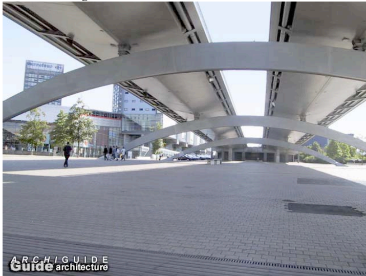
Figure 13 : Photographie de la passerelle Le Corbusier de F. Delaugiers. Source : Archiguide
