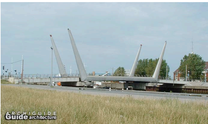
Pont de la Bataille du Texel entre la Citadelle et le Quai des Hollandais, conçu par Pascal Seurin.
