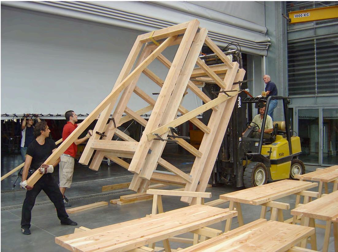
Expérimentation à échelle 1 aux Grands Ateliers de l'Isle d'Abeau. Construction du prototype.
