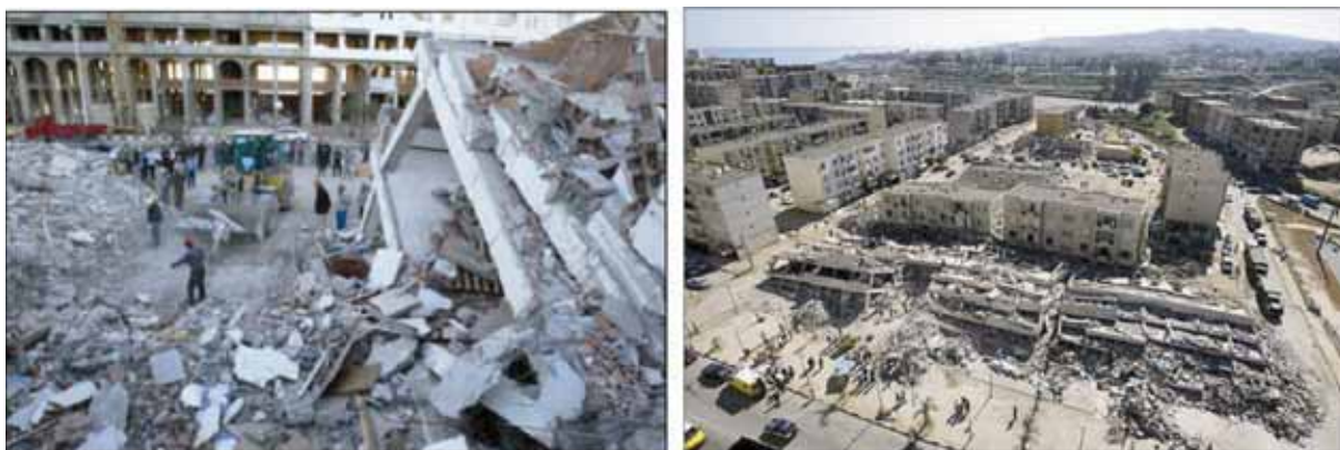
Figure III-14 : Images montrant les dégâts causés par le séisme de Boumerdès (mai 2003).
