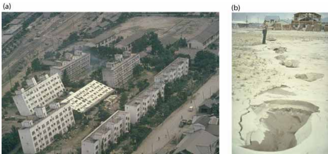
Figure I-21 : Images montrant les désastres causés par la liquéfaction dus au séisme de Niigata 1964 (a) la destruction des bâtiments et (b) liquéfaction du sable avec l'apparition de "sand boils" (source photos : http://www.ce.washington.edu/~liquefaction/html/quakes/niigata/niigata.html ).
