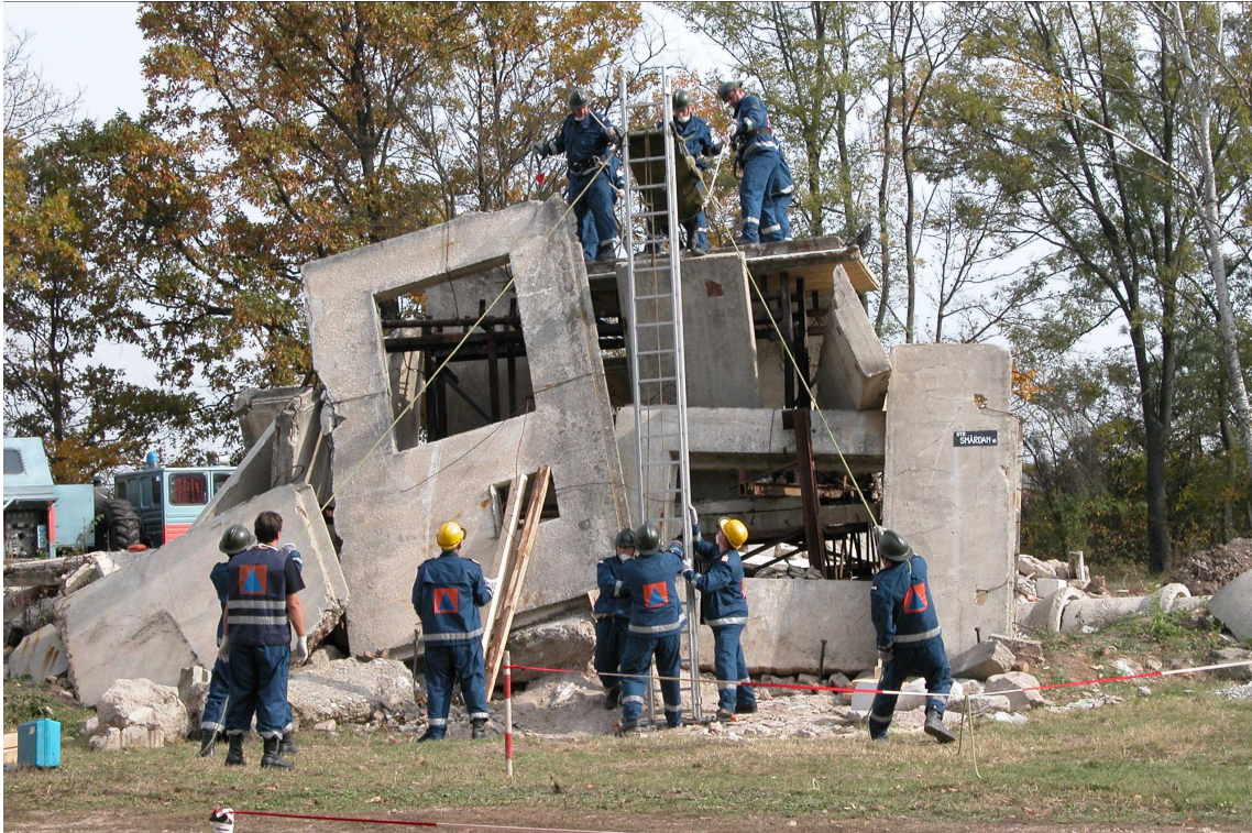
Abbildung 3.1: Bergungsarbeiten an einem zerstörten Gebäude. Bild von der Arbeitsgruppe Disastermanagement-Tool des SFB 461, Bukarest 2004
