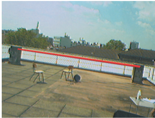
Abbildung 6.7: Geradenstück zwischen zwei Kontrollpunkten; die rote Linie ist als Verbindungslinie zwischen die Mitten der Betonsäulen skizziert.
