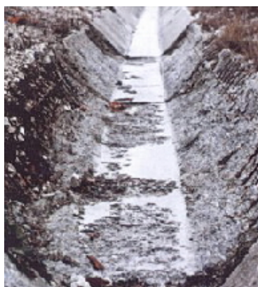
Figure 0.1 : Ecaillage et gel interne d'un caniveau (tiré de [81]).
