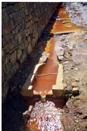
Figure III.27. Point M4, effluent acide de la Mine de Milluni à faible débit assez turbide pendant la saison sèche.
