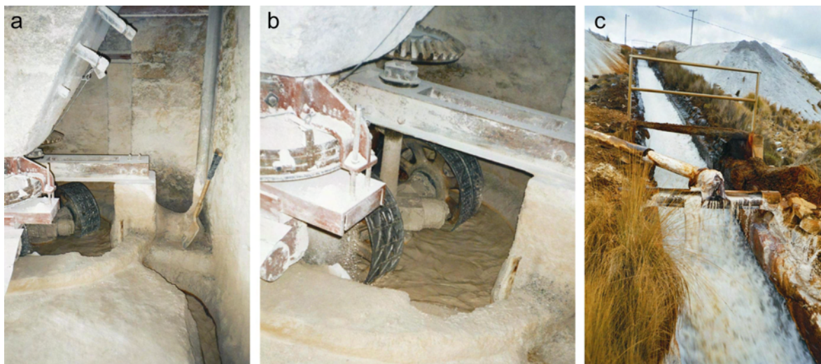
Figure III.28. a, Moulin où est ajouté la chaux à une fraction du canal fournisseur d'eau à La Paz ; b, Détail du moulin ; c, Mélange des eaux avec la chaux dans la partie restante du canal.
