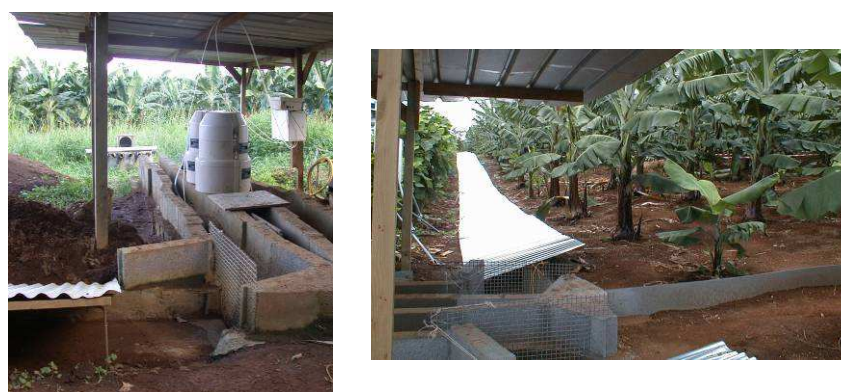
Figure 2-8 Dispositif de suivi hydrologique sur la parcelle Espérance Haut (d'après Cattan et al. (2006)) – en photo : le dispositif de mesure de débit et le canal collecteur.
