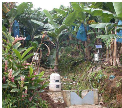
Figure 2-7 Dispositif de suivi hydrologique du sous-bassin Moïse Haut.
