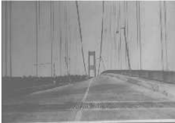
FIG. 4.5.: Phénomène de résonance sur le pont de Tacoma (États Unis) qui entraîna sa destruction en 1940 (d'après http://www.ac-nice.fr/physique/Oscillateur/pont.html )
