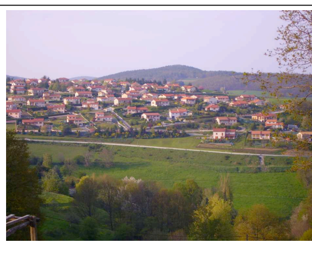
Nouvelles constructions – St Laurent de Chamousset
