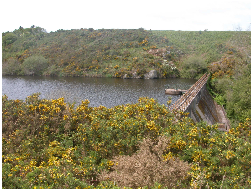
Figure 7.3 : Le barrage de Bordilla, à Belle-Île.
