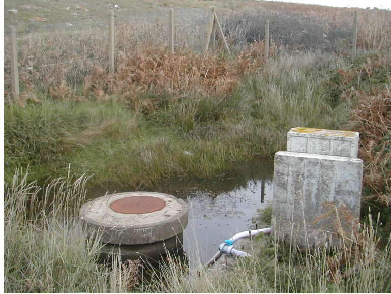
Figure 7.4 : Pompage des eaux de ruissellement du vallon de Porz-Chudel, île de Houat.
