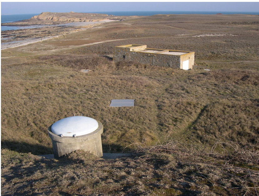
Figure 7.7 : Les infrastructures hydrauliques de l'île d'Hoëdic : au premier plan, un réservoir de stockage ; au second plan, la station de potabilisation.
