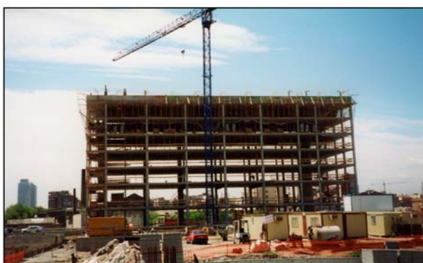
Photo 63. Poble nou (travaux le long du littoral à proximité de Diagonal mar) - © S. Savary
