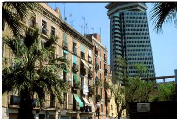
Photo 112. Sud du Raval. A droite la torre de les Drassanes - © P. Putelat
