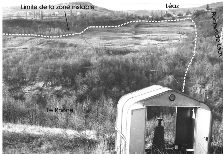
FIG. 8.2 – Photographie du glissement de Léaz prise depuis la rive droite du Rhône (vue vers l'ouest ; Desvarreux, 1972)
