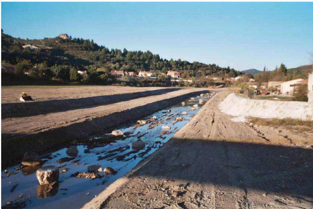
Photographie 4.7 : Le cours de la Berre réaménagé après les crues de 1999 dans la traversée de Durban-Corbières. (cliché : F. Vinet, nov. 2004)
