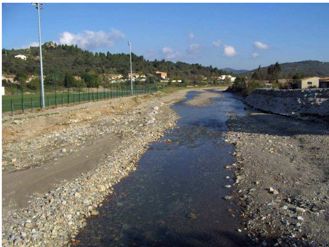
Photographie 4.8 : Le cours de la Berre au même endroit après les crues de novembre 2005 et janvier 2006. Le terrain de sport a été aménagé en rive gauche mais le recalibrage a disparu. On reconnaît l'enrochement à droite (cliché : F. Vinet, nov. 2006)
