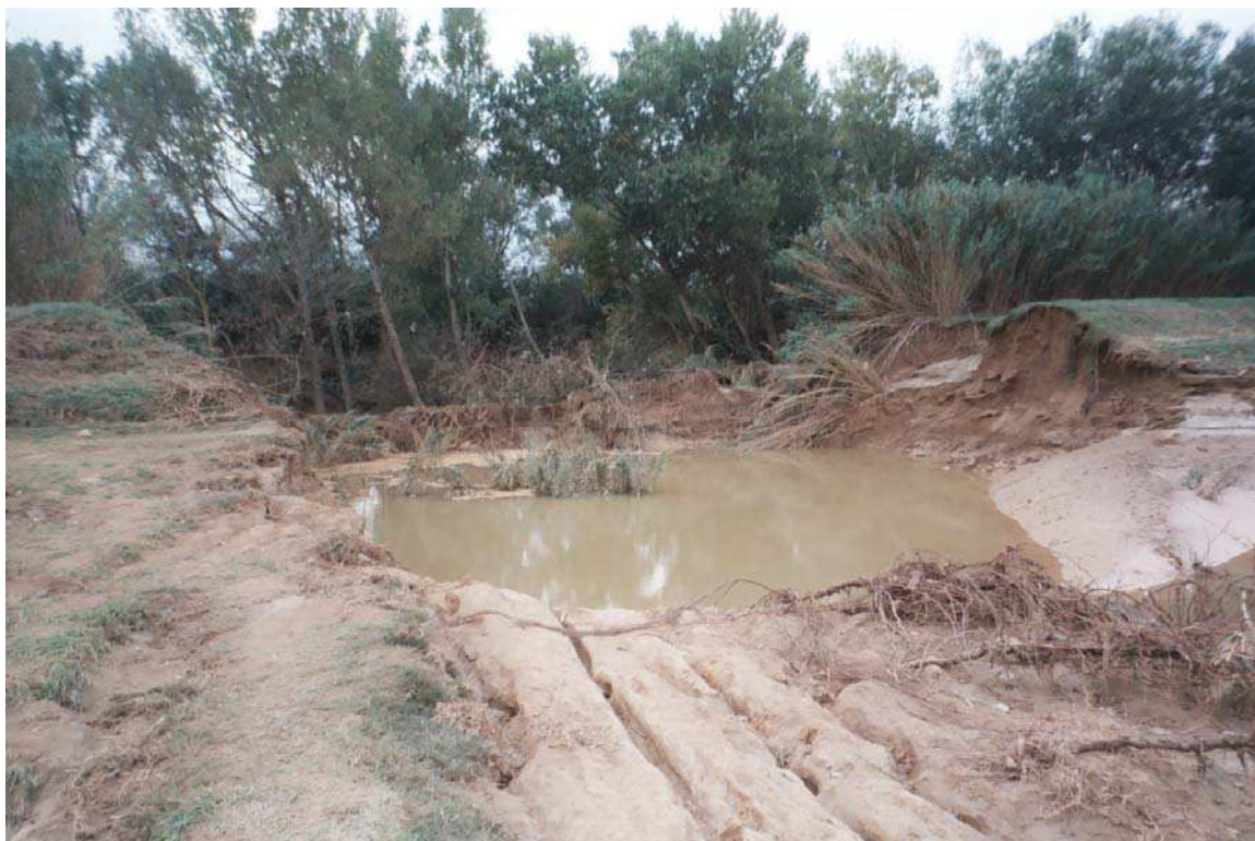
Photographie 3.2 : Brèche dans les digues bordières de l'Aude à Cuxac-d'Aude en novembre 2005
