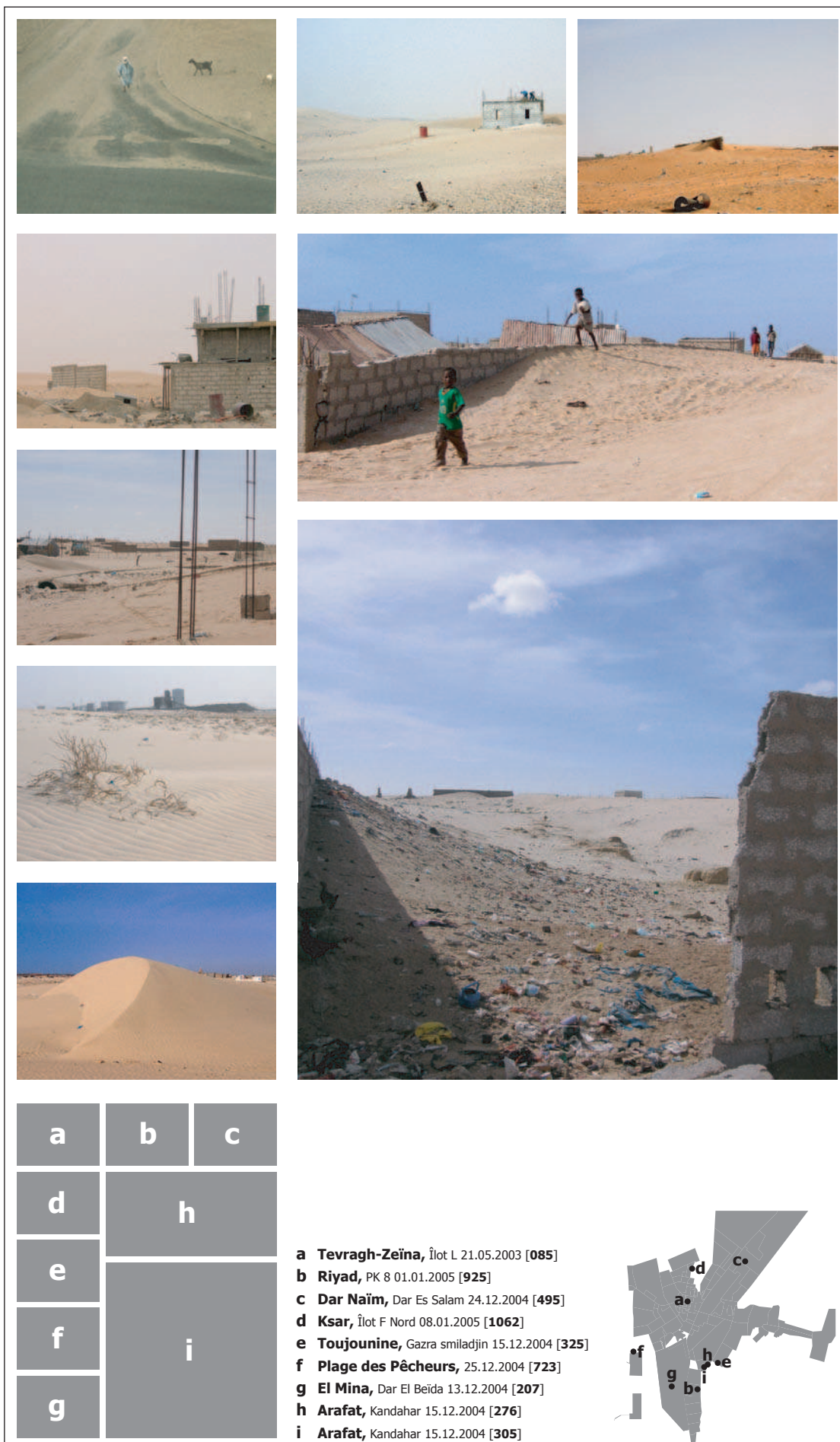
Planche 3 : Les infrastructures ensablées
