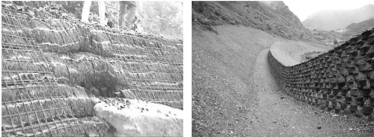
Figure 1.13 Parement amont renforcé par des nappes de géotextile (à gauche) et par des pneusol® (à droite), respectivement d'après Castiglia 2002 et IMS-RN.
