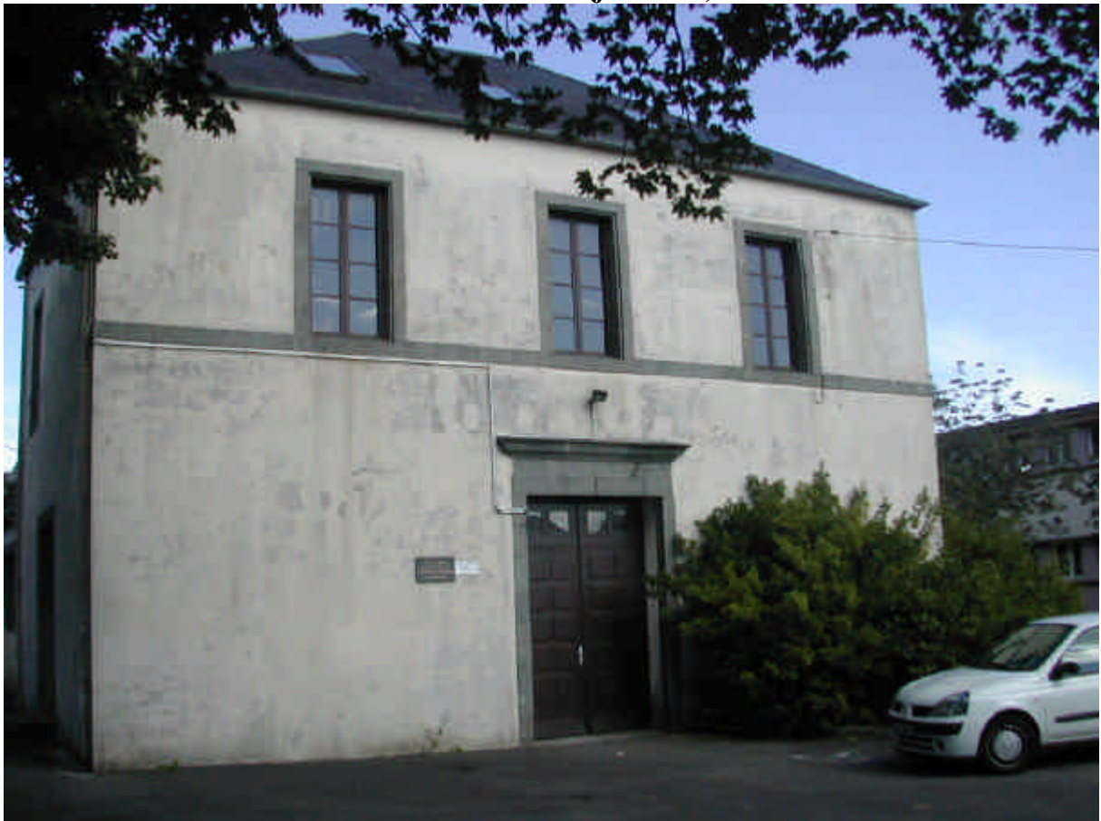
Bâtiment actuel (juin 2004)
