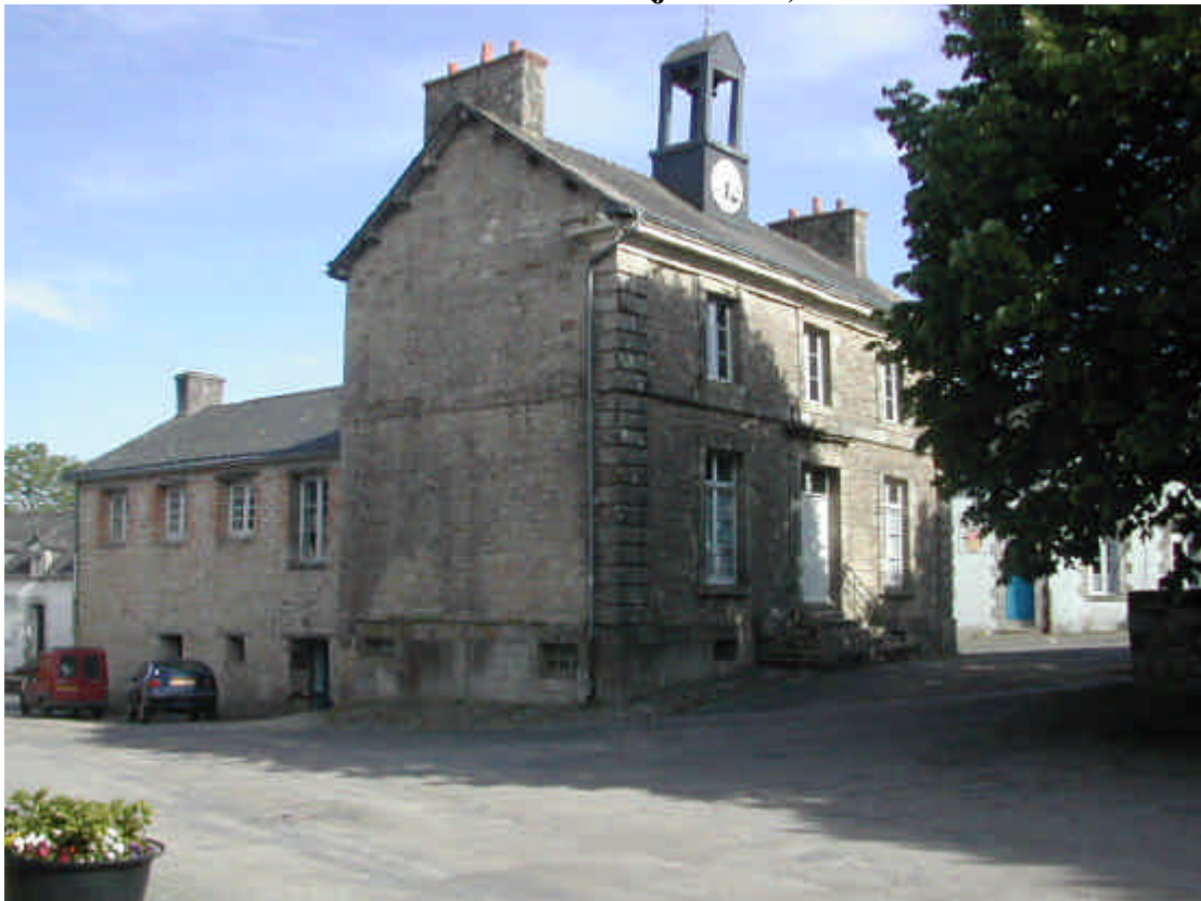
Bâtiment actuel (juin 2004)
