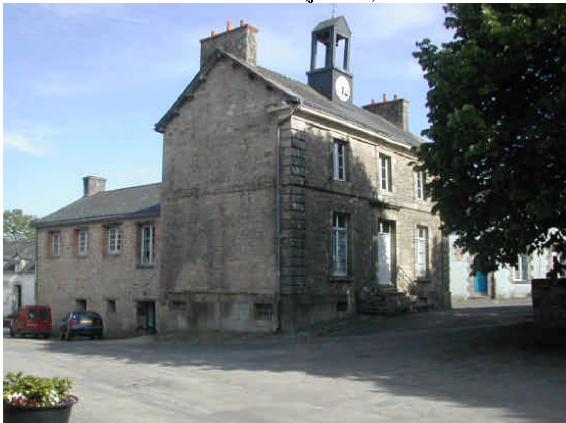
Bâtiment actuel (juin 2004)
