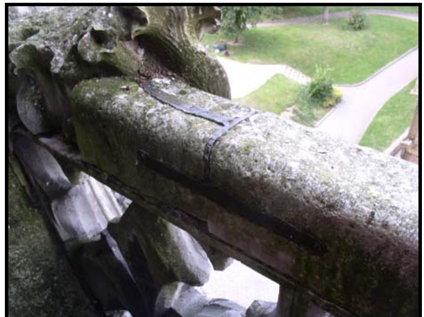
Figure 198 : Divers emplois du fer au niveau de la claire-voie du triforium du Beau Portail de la cathédrale de Troyes. A droite, tirants et agrafe d'attache du fronton ; à gauche, agrafes sur la balustrade.
