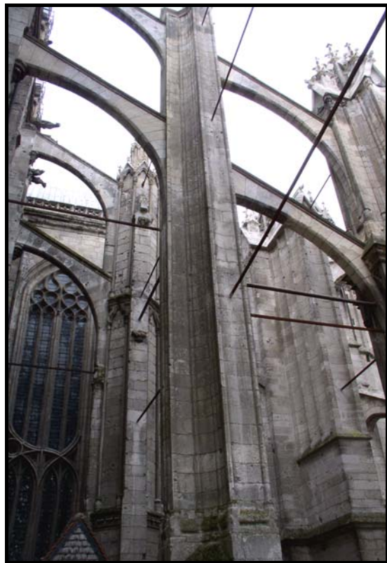
Figure 276 : Divers renforts au niveau des arcs-boutants. En haut, tirants dans les arcatures des arcs-boutants de la cathédrale d'Amiens. En bas à gauche, barres attachant les colonnettes de support à la basilique de Saint-Denis. En bas à droite, tirants dans le chœur de la cathédrale de Beauvais.
