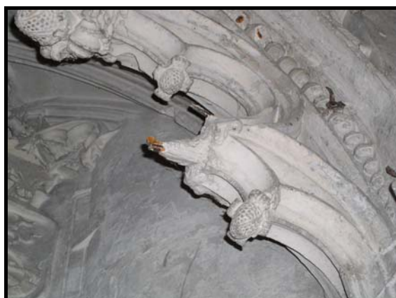
Figure 250 : Arcature à fleurs du jubé de l'église Sainte-Madeleine de Troyes avec des goujons dépassant des fleurs brisées. Au premier plan fleurs de type B et C, en arrière plan, fleurs de type A.
