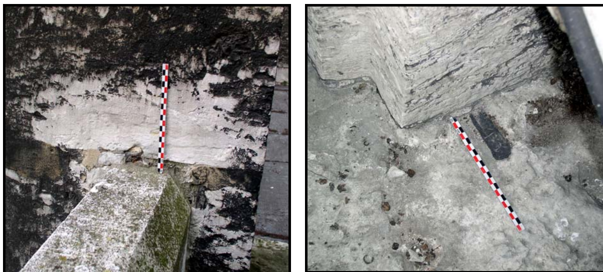
Figure 11 : Agrafes passant dans ou sous un mur, église Saint-Ouen.
