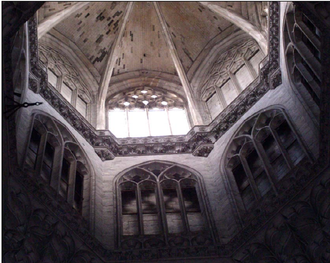
Figure 271 : Tirants dans les arcatures de la tour-lanterne de la cathédrale d'Evreux.
