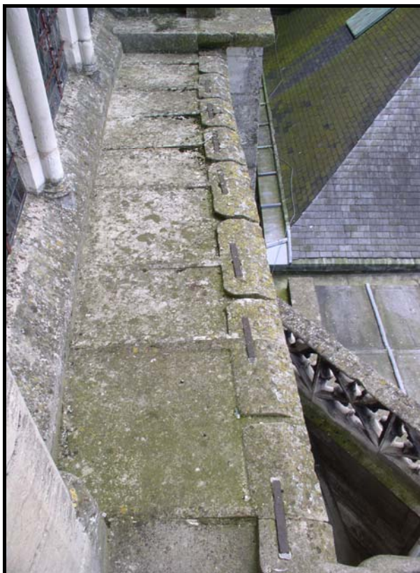
Figure 189 : Agrafes sur la coursiue des fenêtres hautes de la cathédrale de Troyes. En haut, extrémité d'une agrafe qui passe sous le socle d'un pilier ; en bas à gauche, transept nord-ouest travée nord ; en bas à droite, transept nord-est travée centrale.
