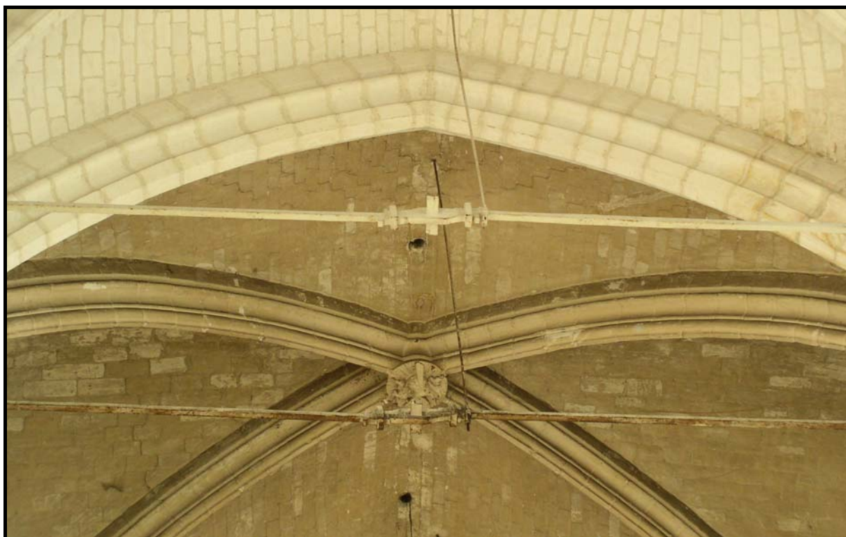
Figure 227 : Tirants dans la nef de l'église Saint-Jean-au-Marché. En haut à gauche, vue générale ; en haut à droite, ancre extérieure bloquant un tirant ; en bas, vue de l'assemblage des tirants.
