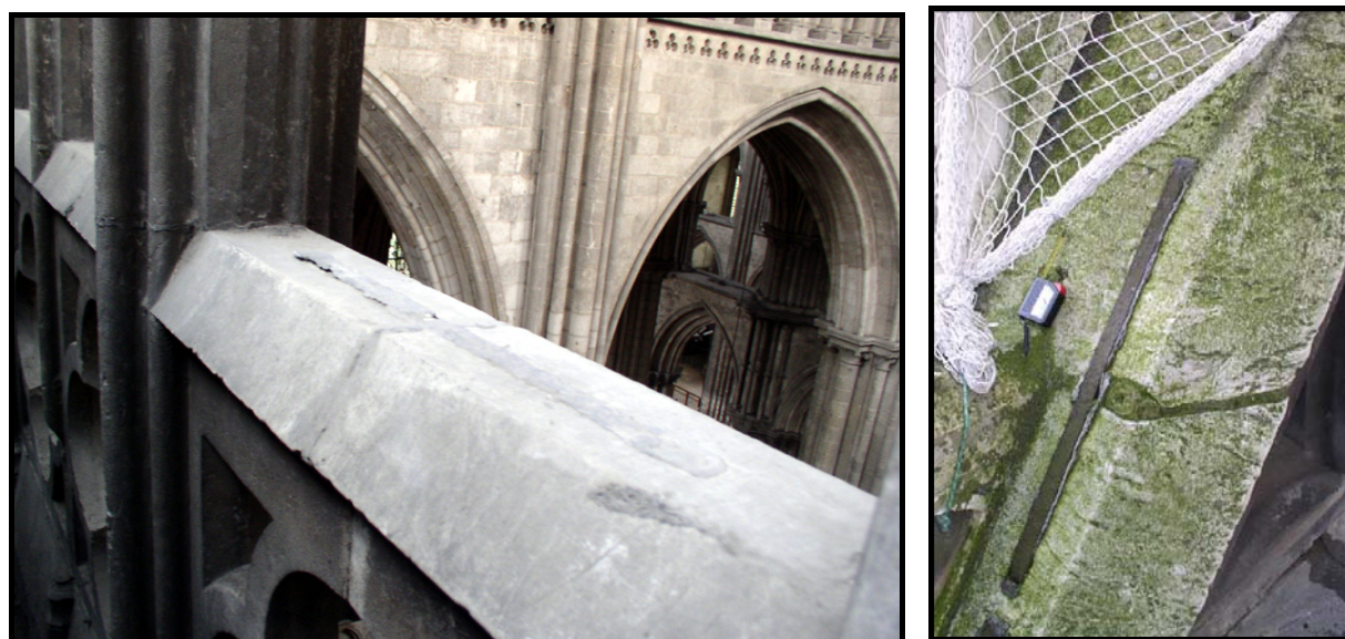
Figure 55 : Agrafes au portail de la Calende. A gauche, au revers, sur la balustrade à hauteur du triforium ; à droite, agrafe du gâble.
