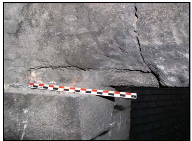
Figure 100 : Barres en linteau à l'étage des combles de l'église Saint-Ouen de Rouen. En haut, plan de la croisée du transept avec leur localisation, d'après un plan de D. Moufle, A.C.M.H. 389 En bas à gauche, barre en linteau à l'entrée est de la croisée. En bas à droite, empreinte d'une barre en linteau déposée au niveau du chéneau du transept nord.
