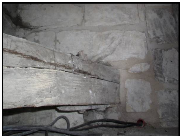
Figure 247 : Chaînage en bois au sol des fenêtres hautes du transept sud de l'église Sainte-Madeleine de Troyes.
