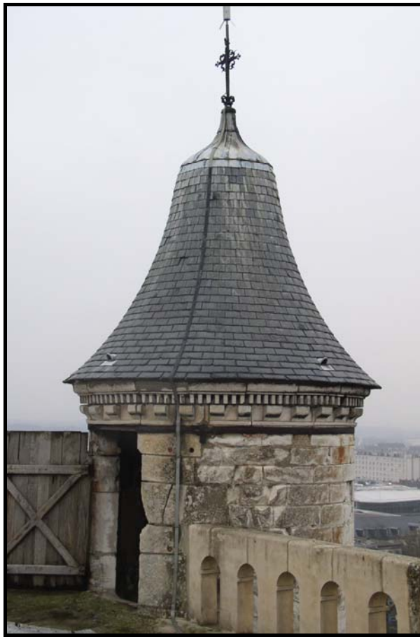
Figure 246 : Chaînage de la tourelle d'escalier de la tour du massif sud de l'église Sainte-Madeleine de Troyes.
