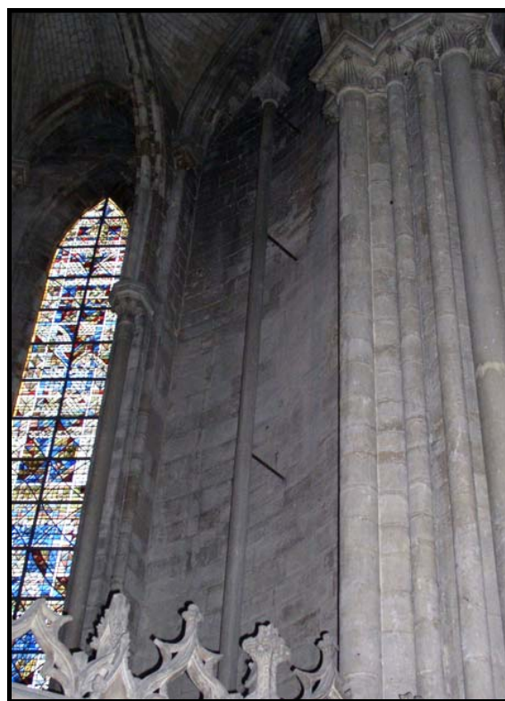
Figure 35 : En haut, petites barres de fer reliant les colonnettes aux piles de la nef de la cathédrale de Rouen, en bas, barres des colonnettes de la chapelle du revestiaire.
