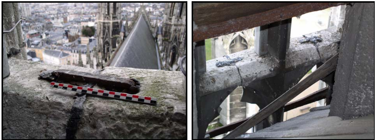
Figure 110 : Agrafes de la balustrade à claire-voie au 2 e étage de la tour de la croisée de l'église Saint-Ouen.
