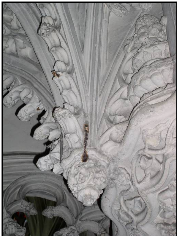
Figure 252 : Agrafe attachant un bouton de clef de voûte du jubé.
