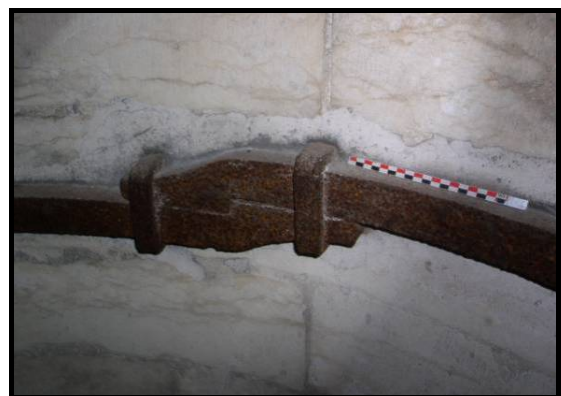
Figure 165 : Cerclage et chaînage au plafond du triforium du transept nord de la cathédrale de Troyes. En haut à gauche, localisation. En haut à droite, partie du chaînage avec vue de l'assemblage entre deux chaînons côté ouest. En dessous, partie terminale du chaînage dans la pile nord-est de la croisée. En bas à gauche, assemblage entre le cerclage et le chaînage dans l'escalier du contrefort nord-est. En bas à droite, assemblage du cerclage.
