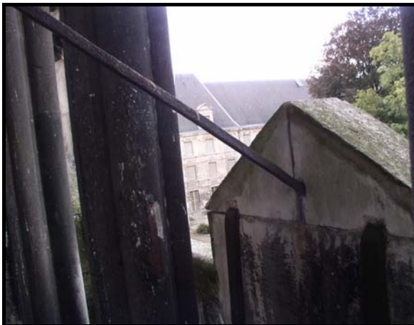
Figure 198 : Divers emplois du fer au niveau de la claire-voie du triforium du Beau Portail de la cathédrale de Troyes. A droite, tirants et agrafe d'attache du fronton ; à gauche, agrafes sur la balustrade.
