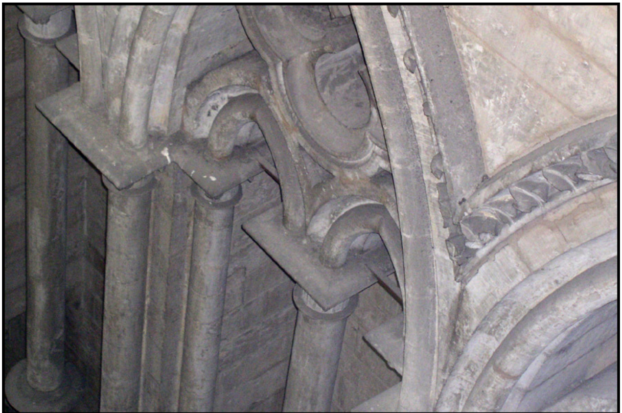
Figure 53 : Tirants ou agrafes présents dans l'arcature du premier étage de la tour-lanterne de la cathédrale de Rouen.
