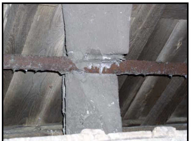
Figure 108 : Tirants du deuxième étage de la tour de la croisée. En haut, tirants du parement extérieur ; au milieu, systèmes de liaison des tirants ; en bas, tirants du parement intérieur.
