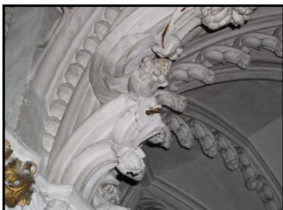
Figure 250 : Arcature à fleurs du jubé de l'église Sainte-Madeleine de Troyes avec des goujons dépassant des fleurs brisées. Au premier plan fleurs de type B et C, en arrière plan, fleurs de type A.
