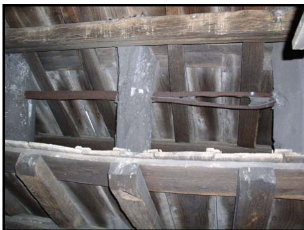
Figure 108 : Tirants du deuxième étage de la tour de la croisée. En haut, tirants du parement extérieur ; au milieu, systèmes de liaison des tirants ; en bas, tirants du parement intérieur.
