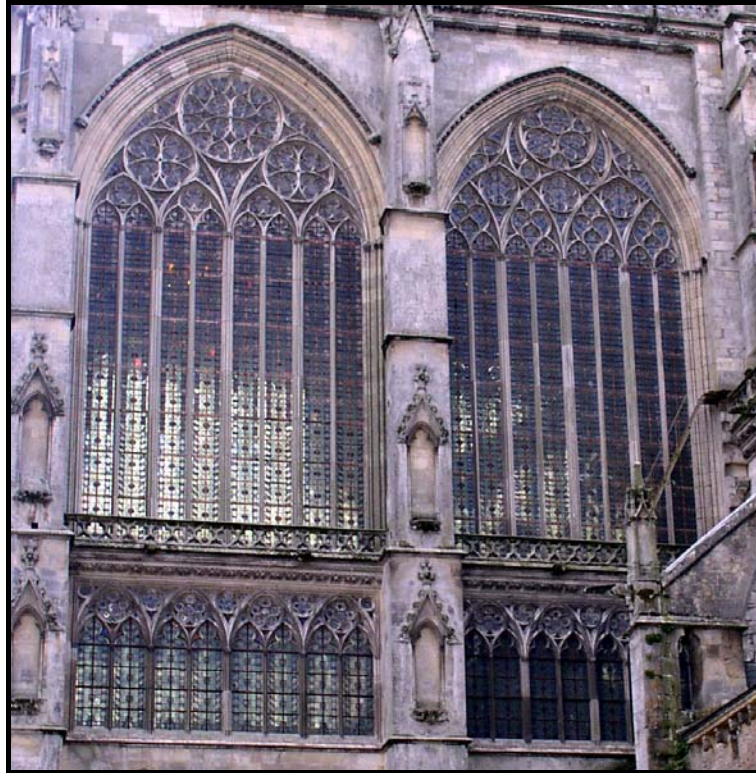
Figure 268 : Baies hautes du transept de la cathédrale du Mans et leurs barlotières-tirants.
