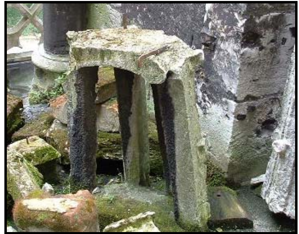
Figure 131 : Fleurons provenant d'une purge du transept nord de l'église Saint-Ouen avec agrafes (OUEN 03) et goujons (OUEN 05).
