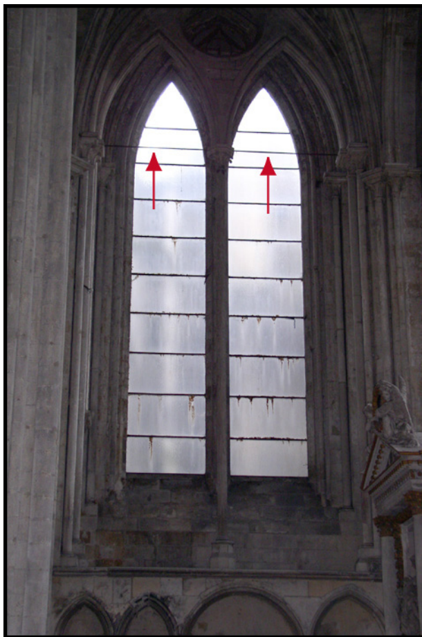
Figure 34 : Tirants des avant-baies du transept de la cathédrale de Rouen, au nord-est (à gauche) et au sud-ouest (à droite).
