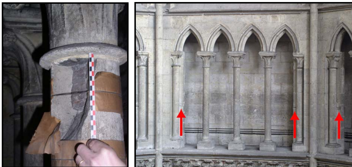
Figure 46 : En bas à gauche, goujon scellé au plomb dans une colonnette. En bas à droite, empreintes dans le triforium du chœur.
