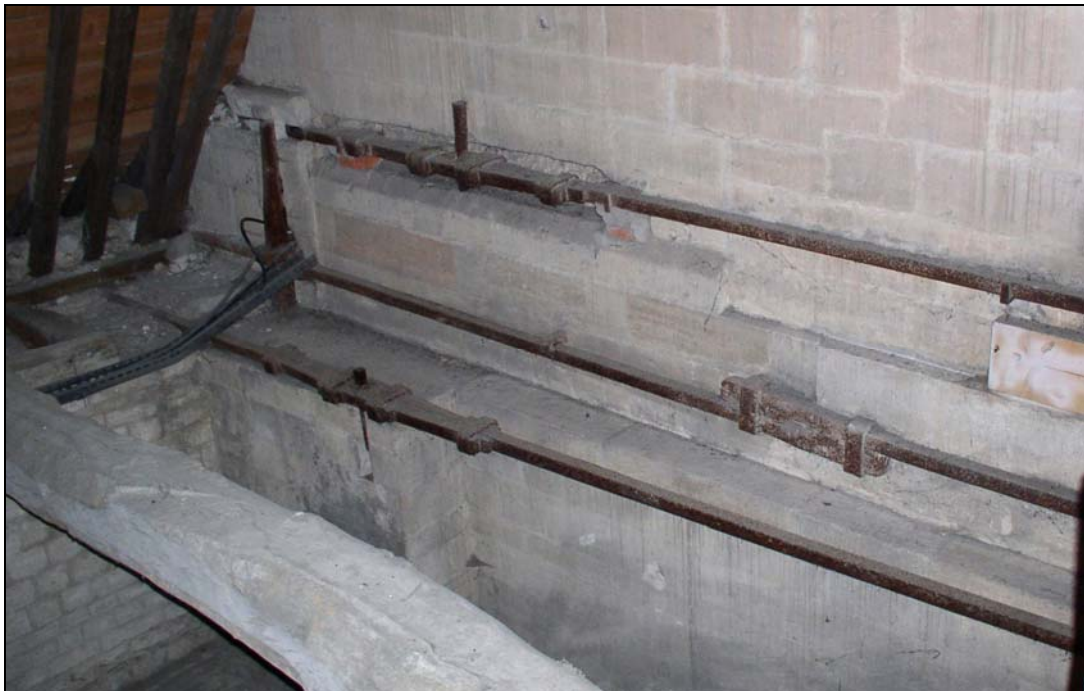
Figure 272 : Chaînages à la base de la tour-lanterne de la cathédrale de Bayeux.
