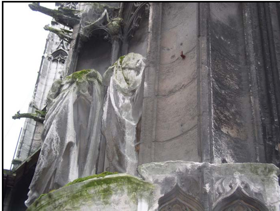
Figure 154: Crochets d'attaches de statues sur la façade.
