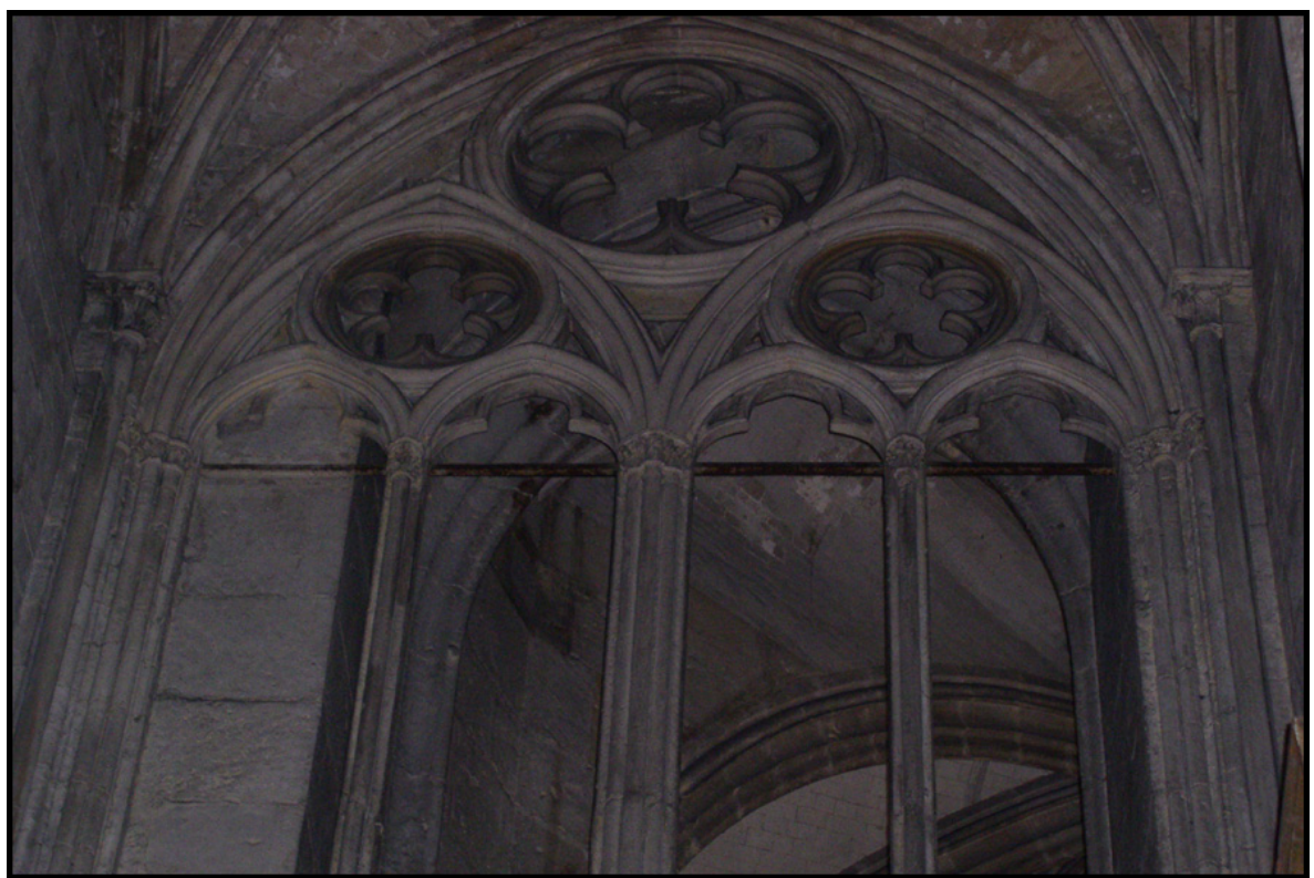
Figure 33 : Tirant des arcs à l'entrée de la tour de Beurre, première travée sud de la nef (en haut à droite) et seconde travée sud (en bas).
