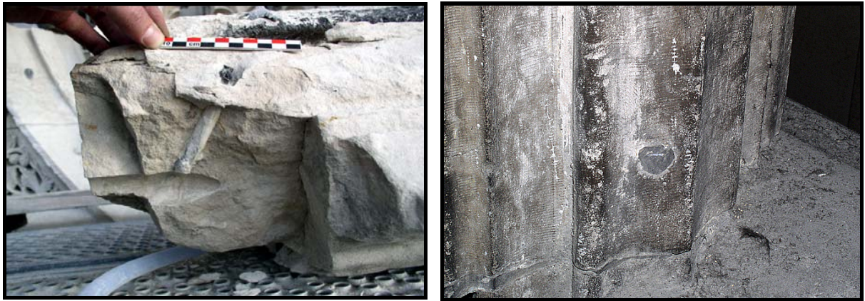
Figure 58 : Présence de meneaux goujonnés sur la façade occidentale de la cathédrale de Rouen.
