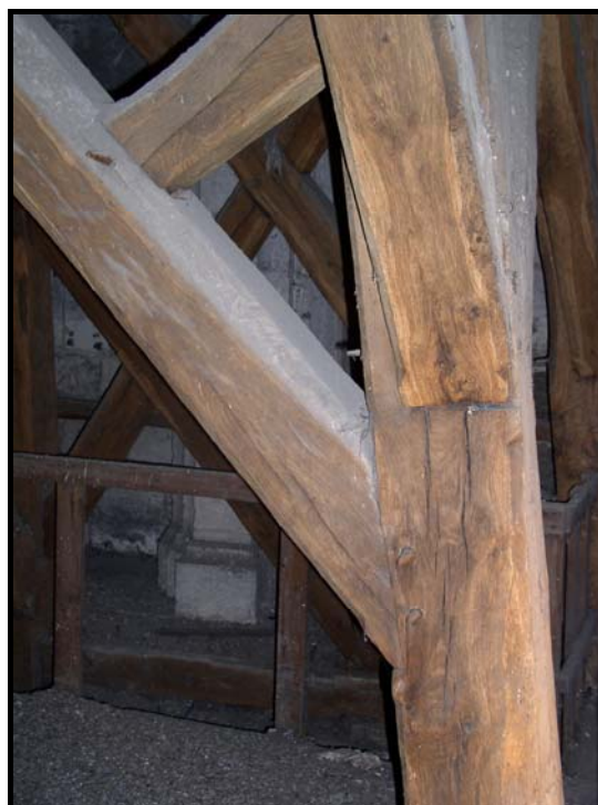
Figure 102 : A gauche, barres de fer dans une niche d'arc-boutant abritant une statue. A droite, chevilles dans le beffroi des cloches de l'église Saint-Ouen.
