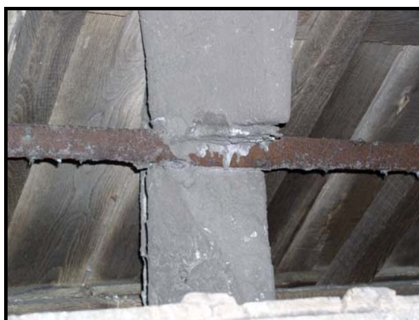
Figure 108 : Tirants du deuxième étage de la tour de la croisée. En haut, tirants du parement extérieur ; au milieu, systèmes de liaison des tirants ; en bas, tirants du parement intérieur.
