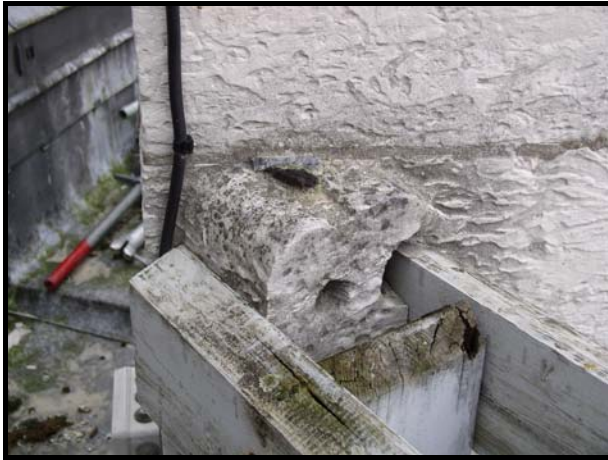
Figure 153: Agrafes coupées et empreintes d'agrafes dans le triforium du chœur de l'église Saint-Maclou.
