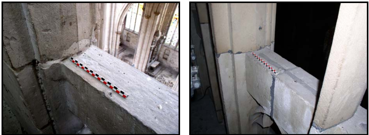
Figure 86 : A gauche, logement d'agrafe passant sous la maçonnerie d'une pile. A droite, agrafe et marque d'une réfection des meneaux.
