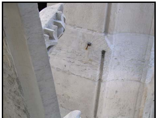
Figure 127 : Eléments de fer au 3 e étage de la tour de la croisée. En haut à gauche, tirants de l'arcature ; en haut à droite, goujon dans le réseau d'un gâble ; au milieu, logement d'agrafe de la balustrade et chaînage d'agrafes dans le couronnement de la tour ; en bas, goujons et section d'agrafe visibles après dépose du gâble et de la balustrade.
