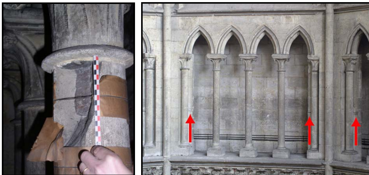
Figure 46 : En bas à gauche, goujon scellé au plomb dans une colonnette. En bas à droite, empreintes dans le triforium du chœur.
