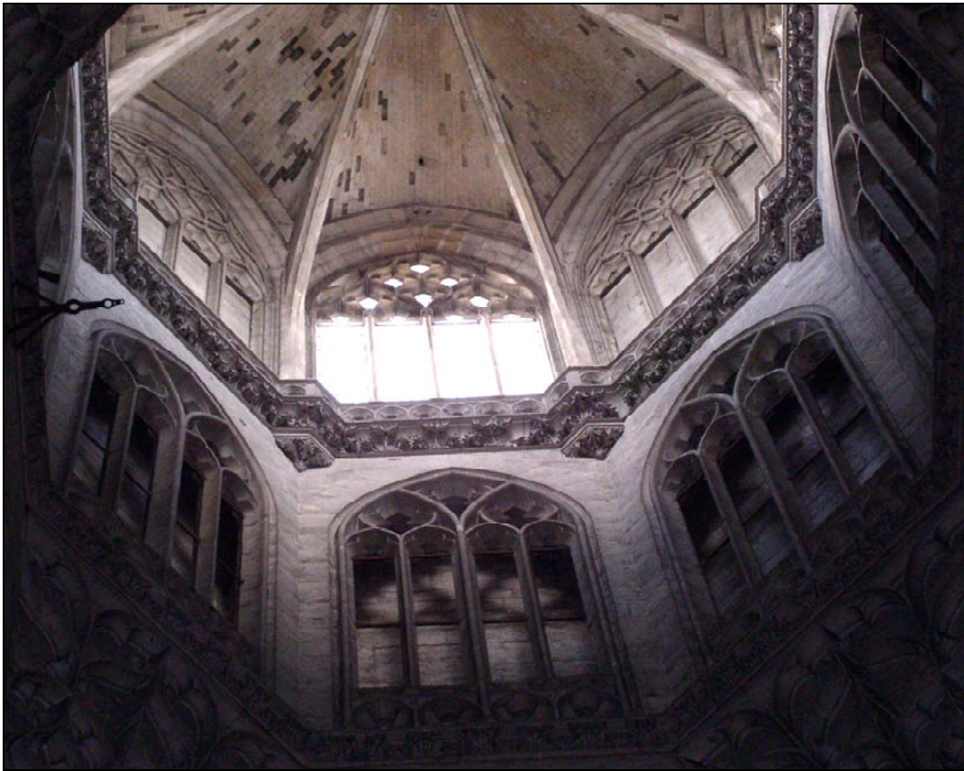
Figure 271 : Tirants dans les arcatures de la tour-lanterne de la cathédrale d'Evreux.
