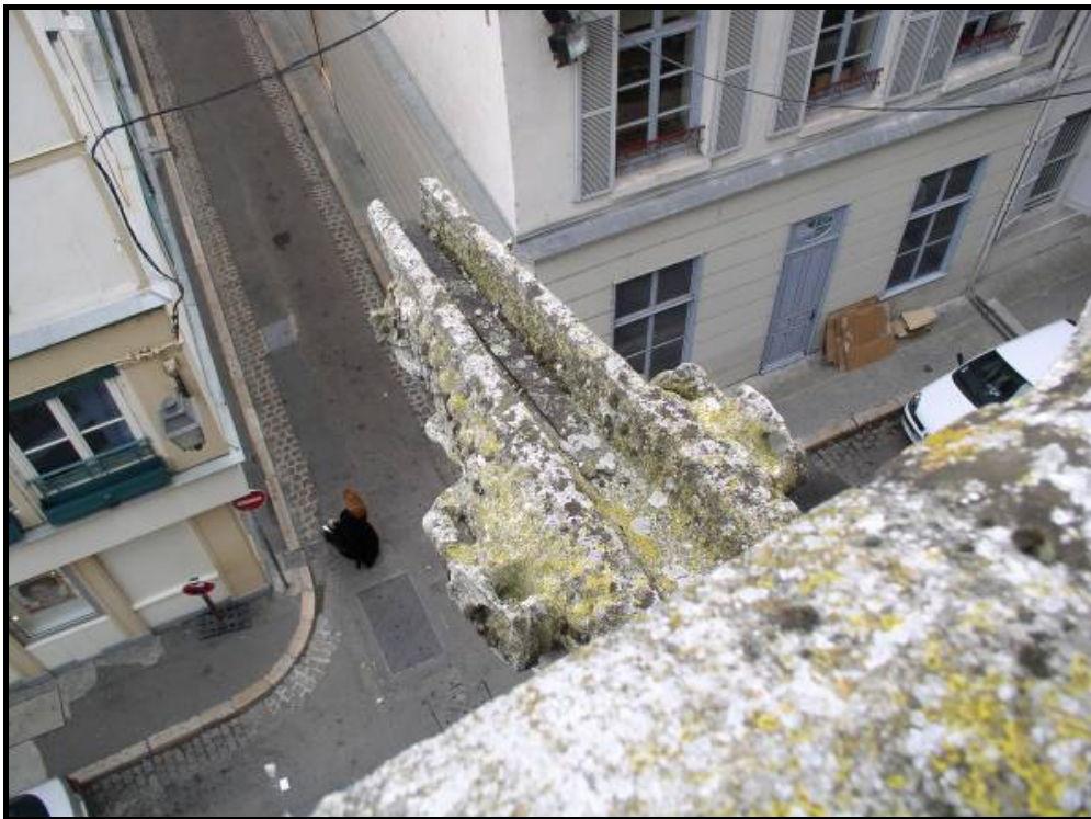
Figure 241 : Barre de fer dans une gargouille de la façade sud de l'église Saint-Jean au Marché.
