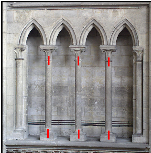
Figure 37: Goujons dans les triforiums de la cathédrale de Rouen. En haut, vue générale du triforium de la nef de la cathédrale de Rouen, 6 e travée sud. Au centre, goujons de la 6 e travée nord (à gauche) et de la 7 e travée nord avec partie de son scellement au plomb (à droite). En bas, localisation des échos correspondant à la présence de goujons, triforium du chœur (à gauche), triforium de la nef travées 1 à 5 (à droite).
