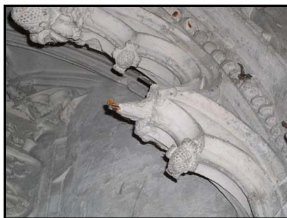
Figure 250 : Arcature à fleurs du jubé de l'église Sainte-Madeleine de Troyes avec des goujons dépassant des fleurs brisées. Au premier plan fleurs de type B et C, en arrière plan, fleurs de type A.
