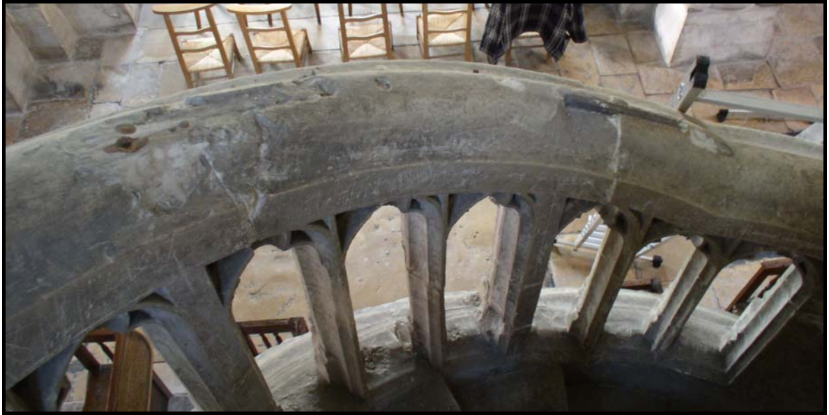
Figure 255 : Agrafes sur la balustrade de l'escalier montant au jubé de l'église Sainte-Madeleine de Troyes.
