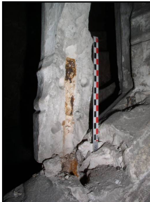
Figure 253 : Emplacement du goujon MAD 01 dans un meneau de la balustrade.
