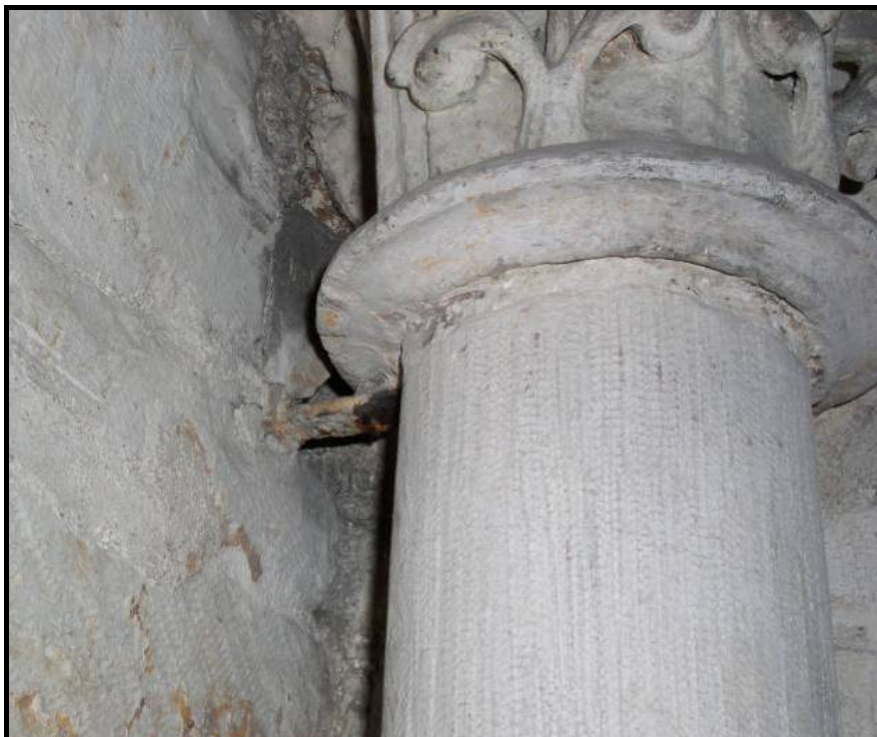
Figure 169 : Petites barres attachant des colonnettes dans le chœur et le transept de la cathédrale de Troyes. Localisation et exemple.
