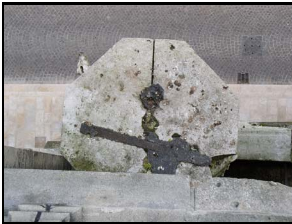
Figure 197 : Goujons attachant les statues sur les socles et dans les niches du Beau Portail de la cathédrale de Troyes.
