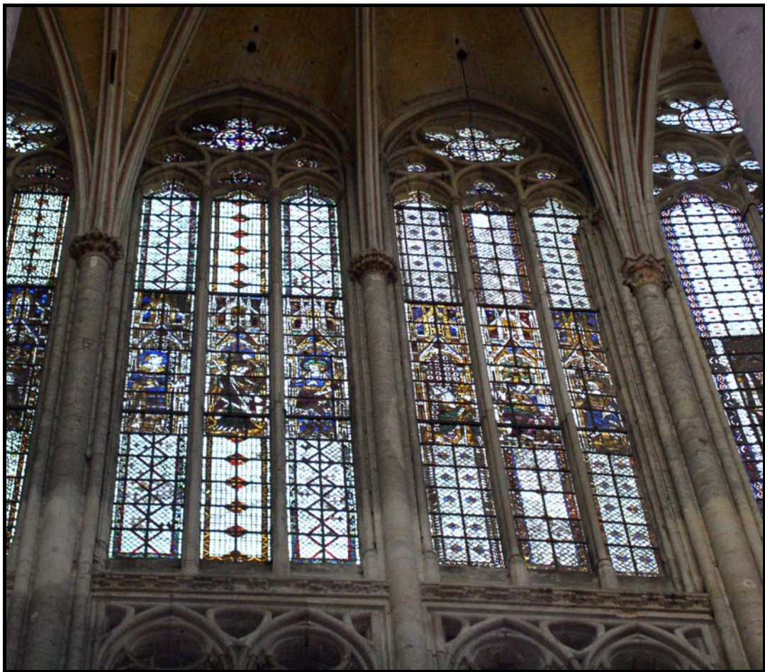
Figure 270 : Baies hautes du chœur de la cathédrale de Beauvais avec leurs tirants.
