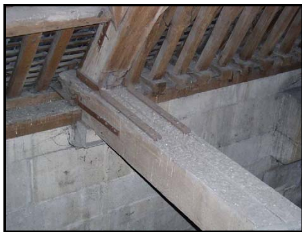
Figure 192 : Fers renforçant les assemblages de la charpente principale de la cathédrale de Troyes. A gauche, assemblage poinçon-entrait dans le transept nord ; à droite, assemblage arbalétrier-entrait dans le chœur.
