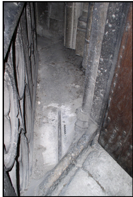
Figure 59 : Tirant au revers de la façade occidentale derrière la grande rose.
