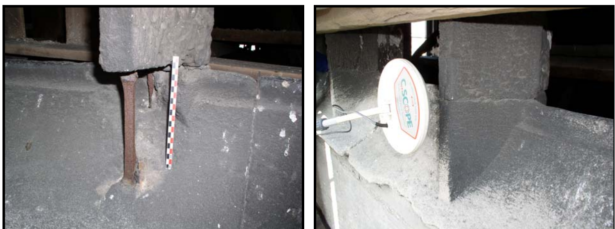
Figure 112 : Petites barres de fer goujonnant les meneaux du parement intérieur du 2 e étage de la tour de la croisée de l'église Saint-Ouen.
