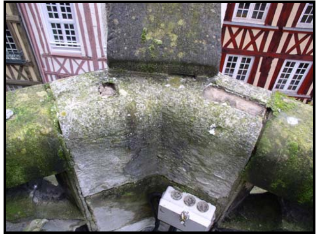
Figure 153: Agrafes coupées et empreintes d'agrafes dans le triforium du chœur de l'église Saint-Maclou.
