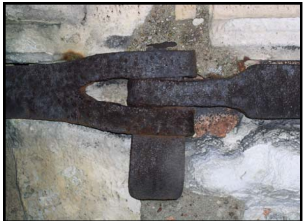
Figure 246 : Chaînage de la tourelle d'escalier de la tour du massif sud de l'église Sainte-Madeleine de Troyes.
