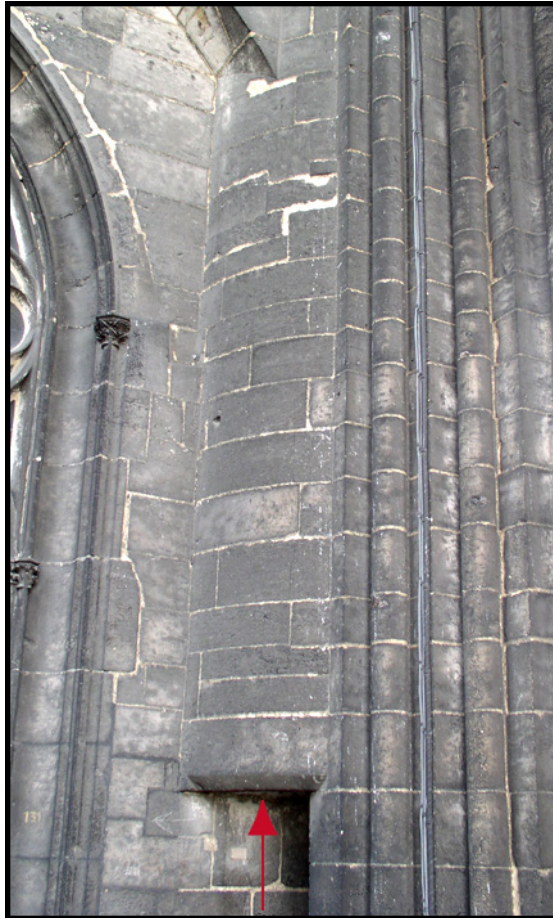
Figure 56 : Barres en linteaux au revers des portails latéraux de la cathédrale de Rouen à l'étage des fenêtres hautes. En haut, portail de la Calende, en bas, portail des Libraires.
