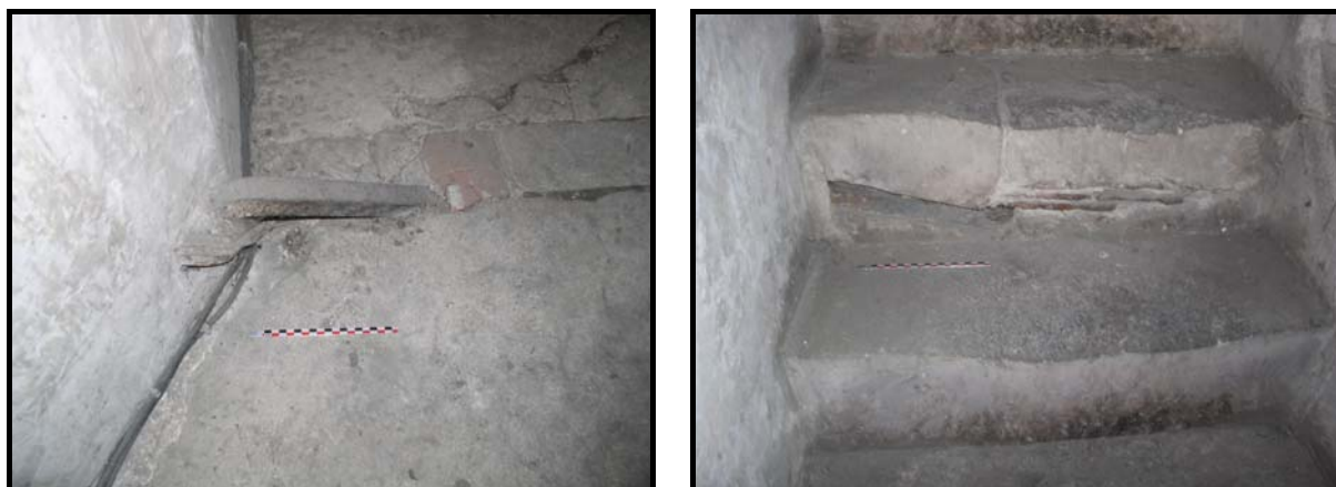
Figure 257 : Barres de fer dans l'escalier du jubé de l'église Sainte-Madeleine de Troyes.
