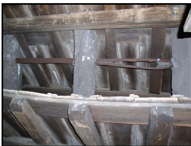
Figure 108 : Tirants du deuxième étage de la tour de la croisée. En haut, tirants du parement extérieur ; au milieu, systèmes de liaison des tirants ; en bas, tirants du parement intérieur.
