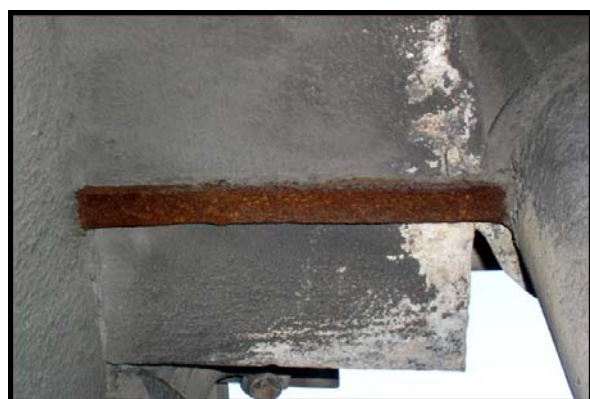
Figure 49 : Petites barres des colonnettes supportant les tours des façades latérales de la cathédrale de Rouen.
