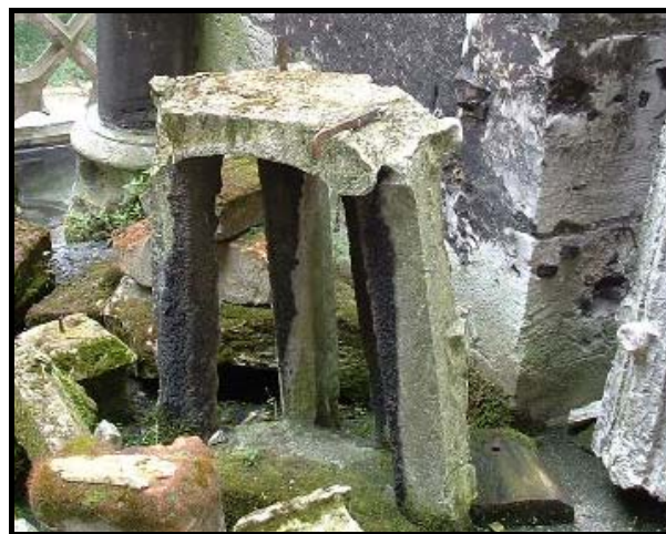
Figure 131 : Fleurons provenant d'une purge du transept nord de l'église Saint-Ouen avec agrafes (OUEN 03) et goujons (OUEN 05).
