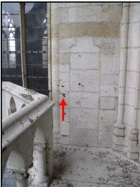
Figure 47 : Empreintes marquant l'agrafage d'anciennes balustrades de la cathédrale de Rouen. En haut, balustrade des fenêtres hautes de la nef, côté nord, clichés Ph. Dillmann. En bas à gauche, modification du tracé de la coursive et de la balustrade des fenêtres hautes de la nef. En bas à droite, empreintes dans les arcs-boutants de la nef côté nord.
