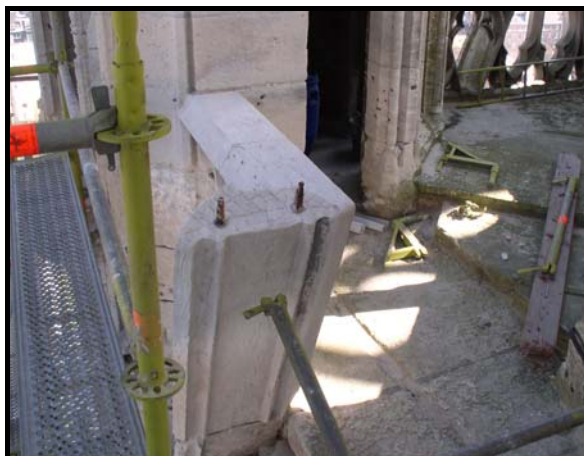
Figure 127 : Eléments de fer au 3 e étage de la tour de la croisée. En haut à gauche, tirants de l'arcature ; en haut à droite, goujon dans le réseau d'un gâble ; au milieu, logement d'agrafe de la balustrade et chaînage d'agrafes dans le couronnement de la tour ; en bas, goujons et section d'agrafe visibles après dépose du gâble et de la balustrade.
