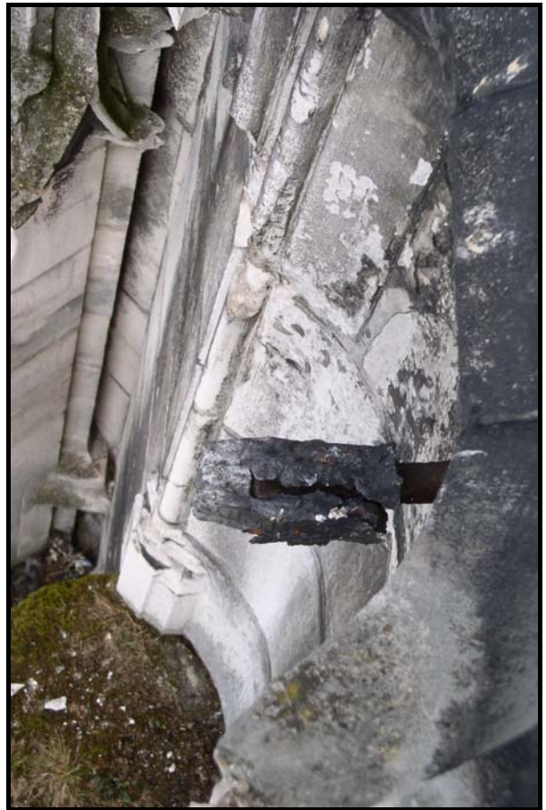
Figure 197 : Goujons attachant les statues sur les socles et dans les niches du Beau Portail de la cathédrale de Troyes.
