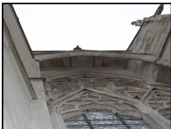
Figure 224 : Système de renforcement des avant-fenêtres de l'abside de l'église Saint-Urbain. En haut, plans et coupes avec localisation, d'après des dessins de Viollet-le-Duc et de Selmersheim. En bas, clichés de ces attaches.
