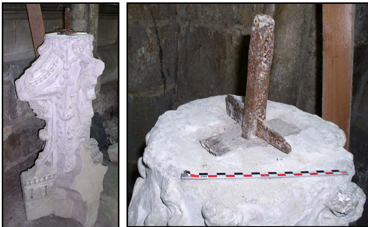
Figure 280 : Système d'attache de bouton de clef de voûte découvert dans le dépôt lapidaire de la cathédrale de Noyon, vers 1520.
