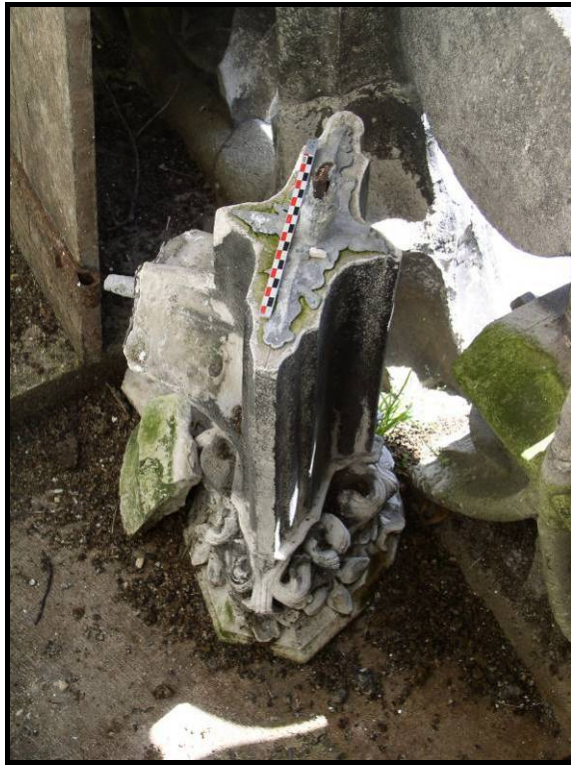
Figure 208 : Goujons sur la façade occidentale de la cathédrale de Troyes. A gauche, dans un meneau brisé, TROY 12 (XVI e s.) ; à droite dans le frontispice de pierre du XIX e siècle, TROY 13.
