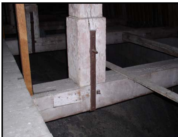
Figure 192 : Fers renforçant les assemblages de la charpente principale de la cathédrale de Troyes. A gauche, assemblage poinçon-entrait dans le transept nord ; à droite, assemblage arbalétrier-entrait dans le chœur.
